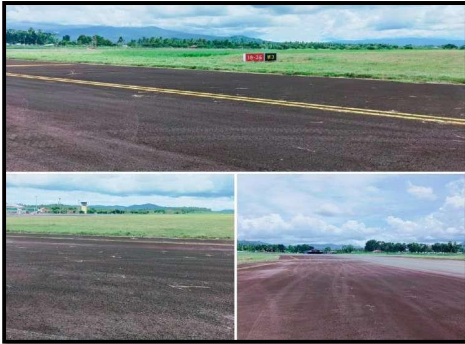
Foto Kondisi taxiway pararell tempat maintenance pesawat
