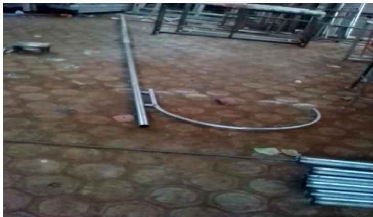
Gambar 3. Penyatuan tiang dan penyangga lampu
