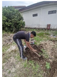
Gambar 4.39 Menyiapkan Material Timbunan
