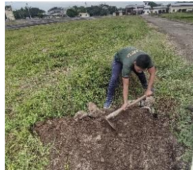
Gambar 4.41 Finishing Penimbunan (Sumber: Dokumentasi Pribadi, Tahun 2024)
