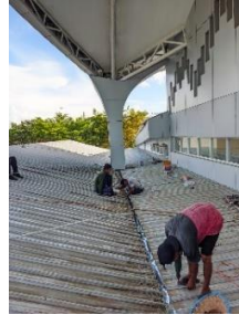
Gambar 4.31 Pemasangan Baut dan Atap
