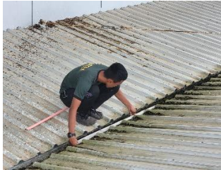
Gambar 4.29 Pelepasan Talang Air Lama
