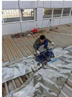
Gambar 4.30 Pemasangan Plat Aluminium
