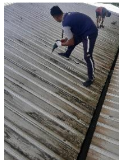
Gambar 4.28 Pelepasan Baut dan Atap
