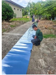
Gambar 4.27 Pengukuran dan Pemotongan Plat Aluminium
