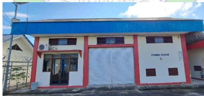
Gambar 4. 10 Gedung Power House (Sumber: Dokumentasi Penulis, 2024)
