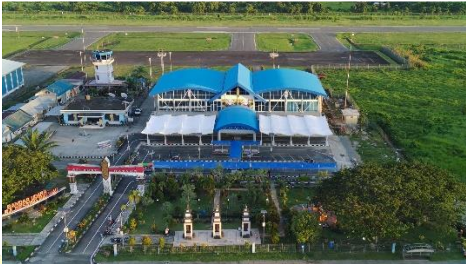
Gambar 2. 1 Bandara Kol. R. A. Bessing, Malinau (Sumber: hubud.dephub.go.id )
