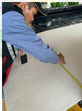
Gambar 4. 15 Pengukuran Kalsiboard (Sumber: Dokumentasi Penulis, 2024)
