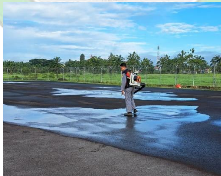
Gambar 4. 13 Pembersihan Water Ponding Menggunakan Kompresor Blower (Sumber: Dokumentasi Penulis, 2024)
