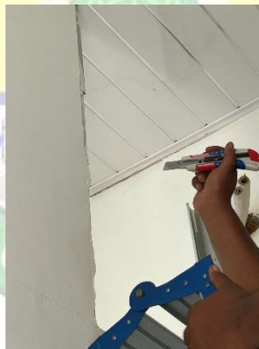
Gambar 4. 17 Pemasangan Dinding Kantor AMC Sumber: Dokumentasi Penulis, 2024
