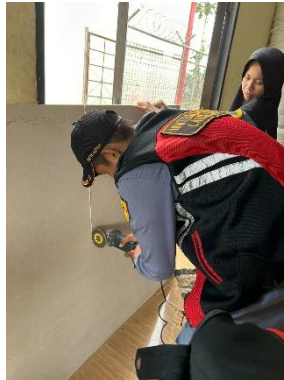
Gambar 4. 16 Pemotongan Kalsiboard Sesuai Ukuran Kerusakan (Sumber: Dokumentasi Penulis, 2024)
