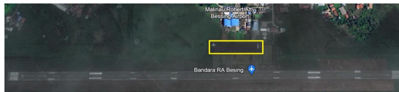
Gambar 4. 3 Tempat Parkir Pesawat ( Apron )
