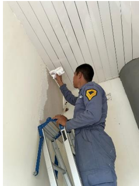
Gambar 4. 20 Pekerjaan Plamiran Dinding Kantor AMC Sumber: Dokumentasi Penulis, 2024
