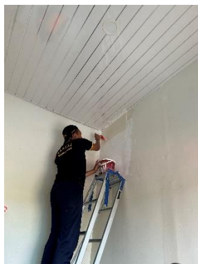
Gambar 4. 22 Proses Pekerjaan Pengecatan Dinding Kantor AMC
