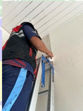
Gambar 4. 18 Pemasangan Fiber Glass Tape Sumber: Dokumentasi Penulis, 2024
