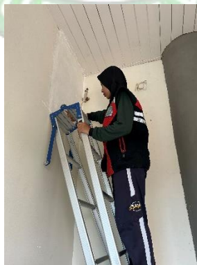
Gambar 4. 21 Proses Pengamplasan Dinding Kantor AMC Sumber: Dokumentasi Penulis, 2024
