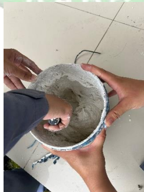
Gambar 4. 19 Pembuatan Adukan Plamir Dinding Kantor AMC Sumber: Dokumentasi Penulis, 2024
