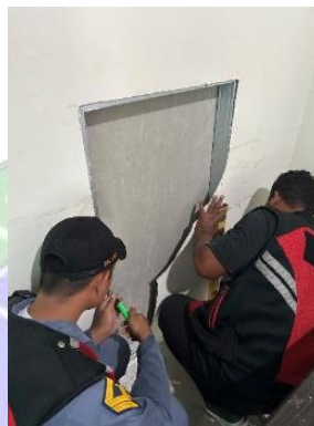
Gambar 4. 14 Pembongkaran Dinding Kantor AMC (Sumber: Dokumentasi Penulis, 2024)
