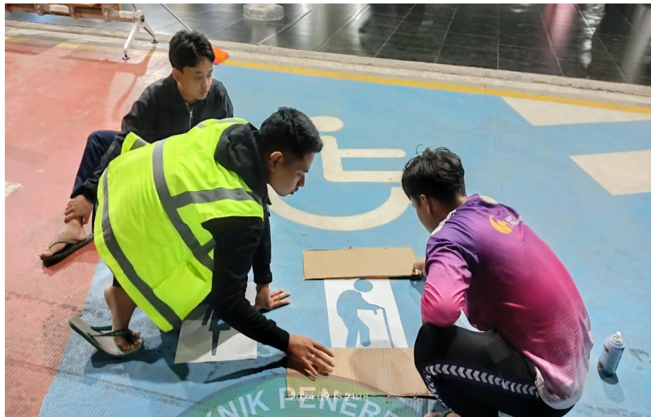
Gambar 4. 33 Proses Pengerjaan Marka Khusus Disabilitas di Area Drop Zone
