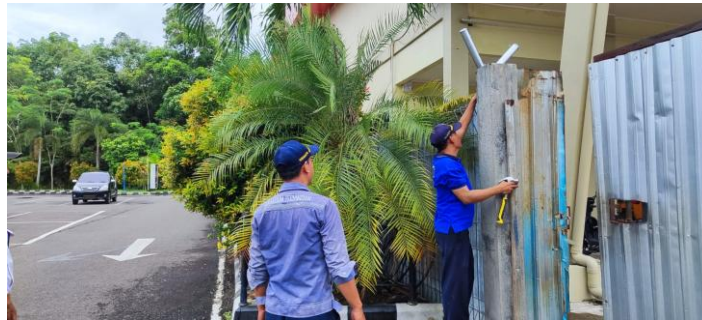
Gambar 4. 16 Pemasangan Tiang Besi Y
