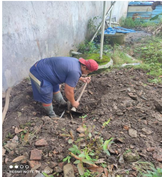
Gambar 4. 21 Pembuatan Kolam Resapan dan Pembersihan Septictank Dokumen Pribadi
