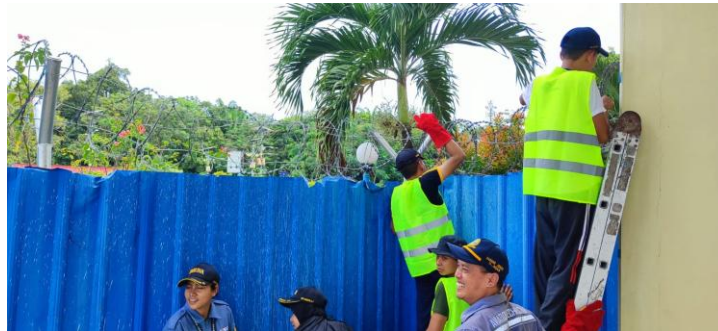
Gambar 4. 18 Pengikatan Kawat Pada Tiang Besi Y
