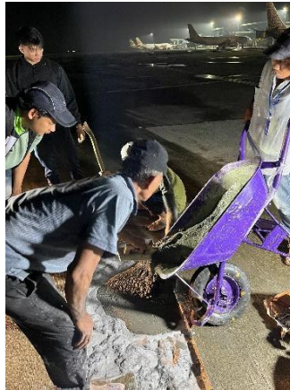
Gambar 4. 20 Penuangan pasta semen sampai setengah dari tinggi kerusakan
