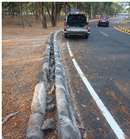
Gambar 4. 29 Mengisi rongga kanstin dengan material
