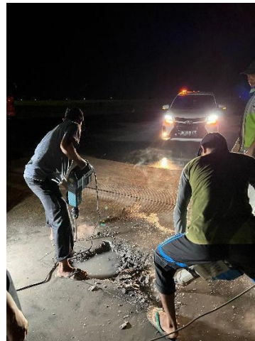
Gambar 4. 15 Pembongkaran area kerusakan menggunakan jackhammer
