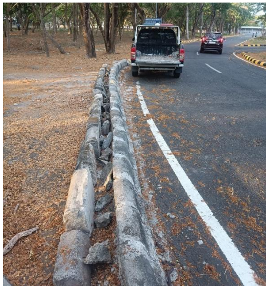
Gambar 4. 31 Kondisi setelah pemasangan kanstin
