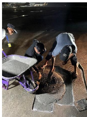
Gambar 4. 22 Penuangan pasta semen sampai ketinggian yang dicari
