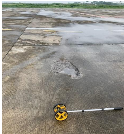
Gambar 4. 13 Pengukuran area kerusakan
