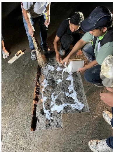
Gambar 4. 19 Pelapisan addibond
