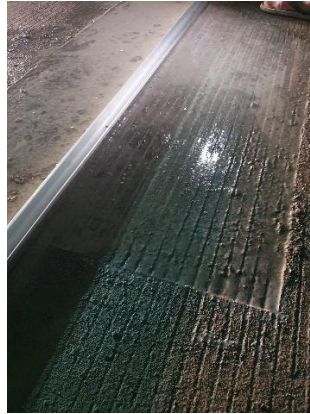
Gambar 4. 23 Penggambaran motif garis pada permukaan beton
