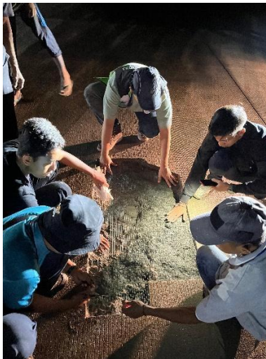
Gambar 4. 18 Pengukuran kawat ayam.
