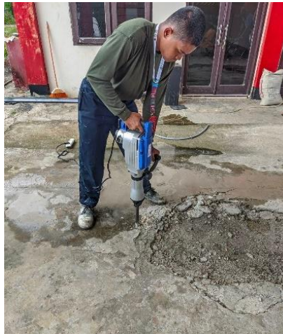
Gambar 4. 33 Pembongkaran Beton Menggunakan Jack Hammer (Sumber: Dokumentasi Penulis, 2024)
