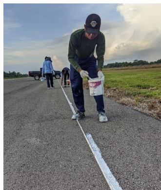
Gambar 4. 20 Membuat Sketsa Mal Dengan Kuas (Sumber: Dokumentasi Penulis, Tahun 2024)
