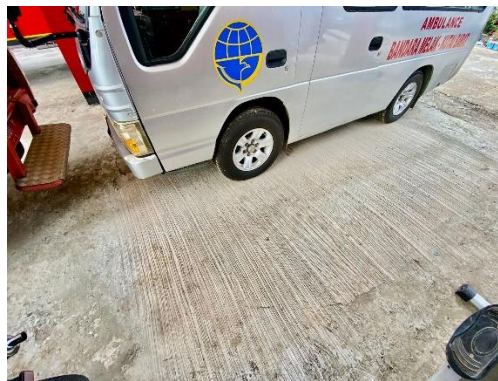
Gambar 4. 37 Hasil Patching Area Parkir PKP-PK (Sumber: Dokumentasi Penulis, 2024)
