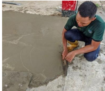
Gambar 4. 36 Meratakan Menggunakan Alat Plester (Sumber: Dokumentasi Penulis, 2024)
