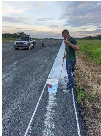
Gambar 4. 21 Pengecatan Dengan Rol (Sumber: Dokumentasi Penulis, Tahun 2024)
