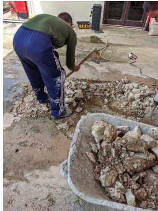
Gambar 4. 34 Pembersihan Material (Sumber: Dokumentasi Penulis, 2024)
