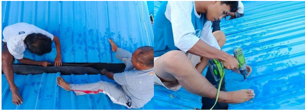
Gambar 4. 35 Menyelipkan Karpet Talang dan Pemasangan Sekrup Kembali (Sumber: Dokumentasi Pribadi, 2024)
