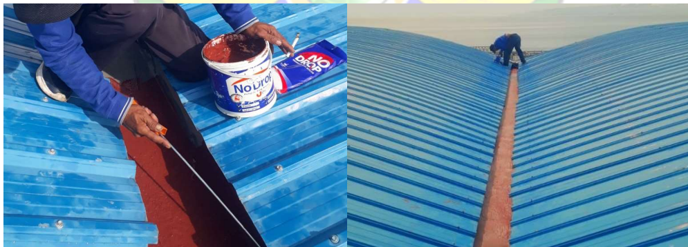
Gambar 4. 36 Pengecatan Karpet Talang dengan Cat No Drop dan Hasil Akhir Perbaikan Talang (Sumber: Dokumentasi Pribadi, 2024)
