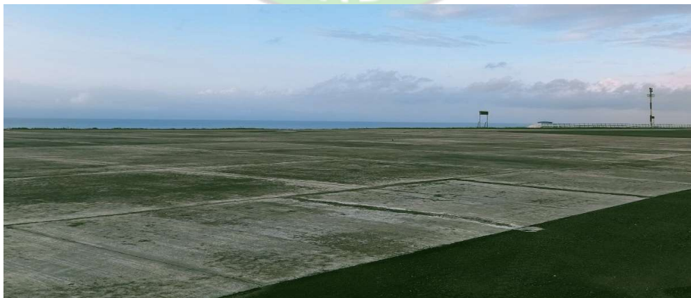
Gambar 4. 6 Apron Rigid Bandar Udara Syukuran Aminuddin Amir Luwuk (Sumber: Dokumentasi Pribadi, 2024)
