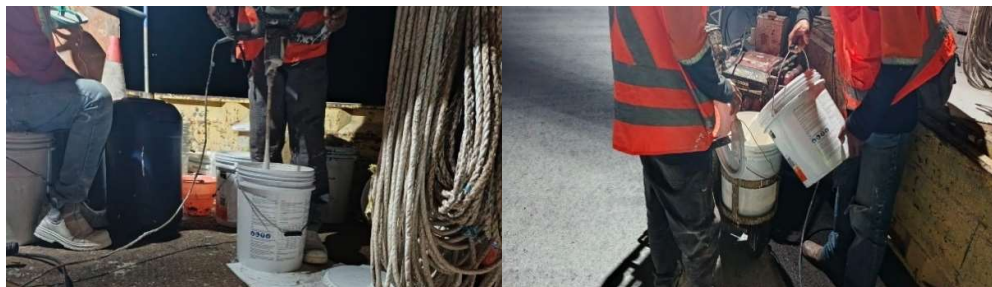
Gambar 4. 20 Pencampuran Cat dengan Air dan Pemindahan Cat ke Alat Semprot Cat (Sumber: Dokumentasi Pribadi, 2024)
