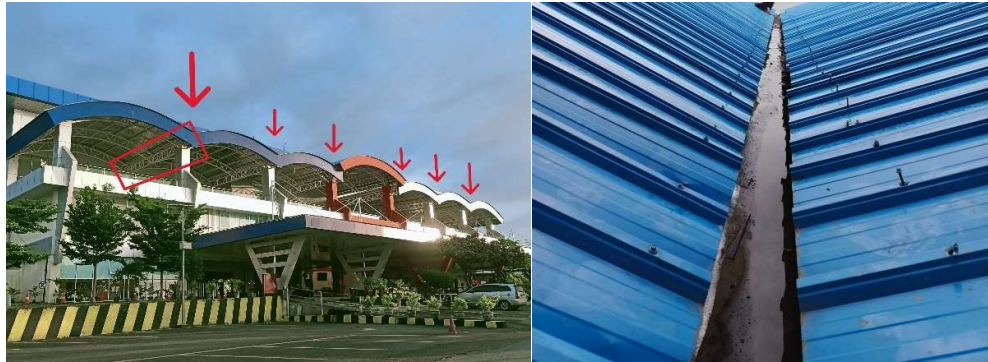
Gambar 4. 16 Letak Kebocoran Talang pada Terminal (Sumber: Dokumentasi Pribadi, 2024)
