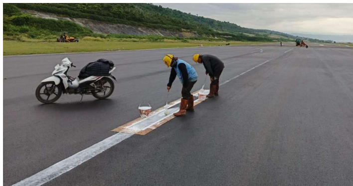
Gambar 4. 22 Pembuatan Marka Runway Centre Line Sementara (Sumber: Dokumentasi Pribadi, 2024)
