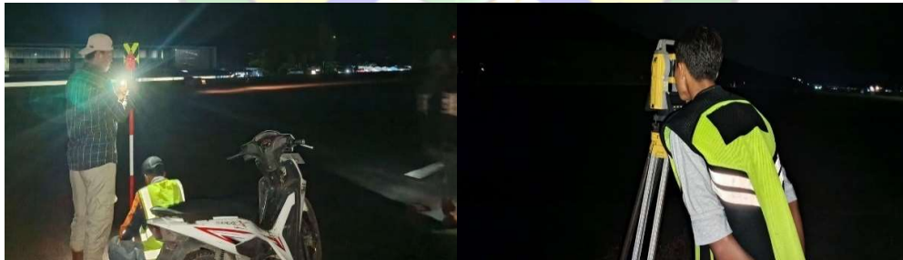
Gambar 4. 19 Proses Penentuan Titik Tengah Runway (Sumber: Dokumentasi Pribadi, 2024)
