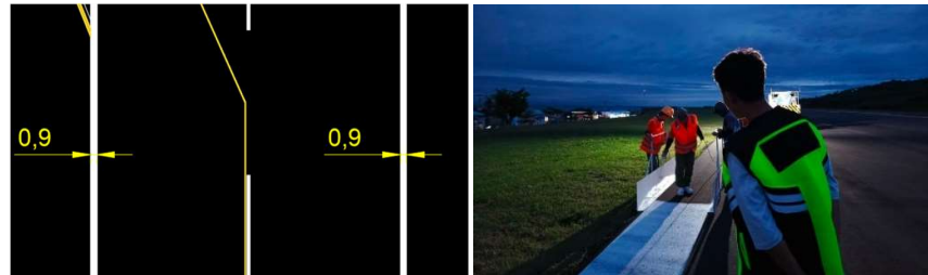
Gambar 4. 23 Dimensi dan Pembuatan Runway Side Stripe Marking (Sumber: Dokumentasi Pribadi, 2024)
