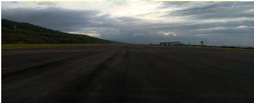
Gambar 4. 15 Runway Tanpa Marka Setelah Proses Overlay (Sumber: Dokumentasi Pribadi, 2024)
