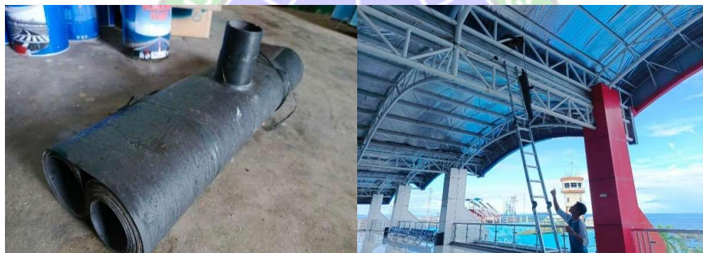
Gambar 4. 33 Hasil Pelekatan Karpet dan Corong Talang serta Pengangkutan Alat Bahan (Sumber: Dokumentasi Pribadi, 2024)
