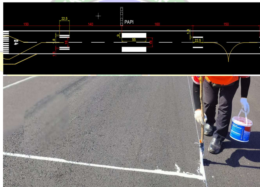
Gambar 4. 28 Dimensi dan Pembuatan Touchdown Zone Marking (Sumber: Dokumentasi Pribadi, 2024)
