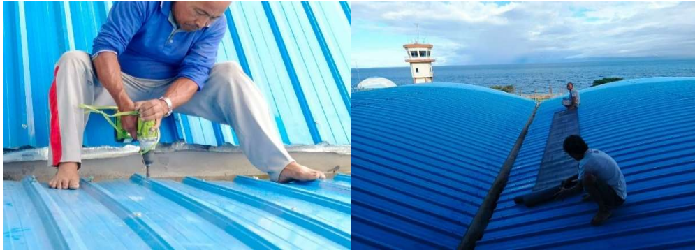
Gambar 4. 34 Pencopotan Sekrup dan Penebaran Karpet Talang (Sumber: Dokumentasi Pribadi, 2024)
