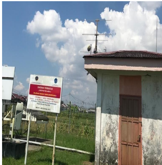
Gambar 3 . 45 Shelter Middle Marker Thales Sumber : Dokumentasi Penulis (2024)
