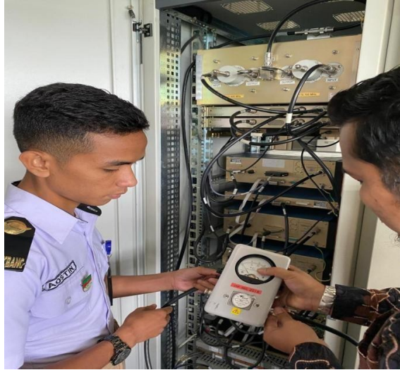
GambarLampiran3. Mengukur Power reflected & Forward Menggunakan Wattmeter
