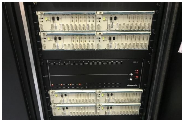
Gambar 3 . 5 Adtran Channel Bank Sumber ; Dokumentasi Penulis (2024)
