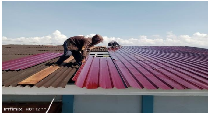
Gambar 4.14 Proses Penyusunan Atap Baru
