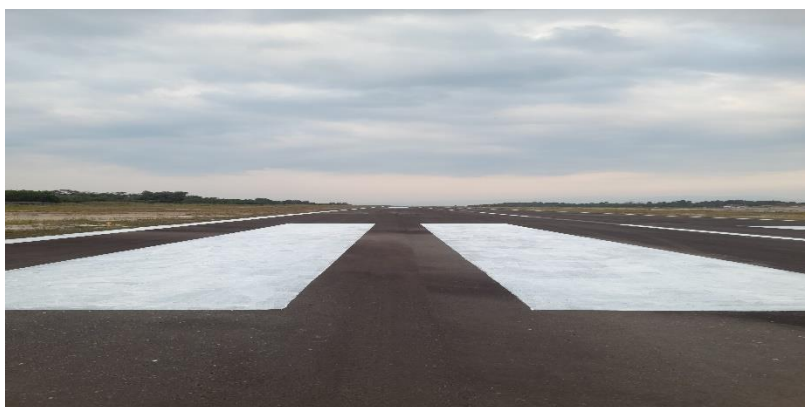
Gambar 2.25 Marka Touchdown Zone Setelah Proses Pengecatan
