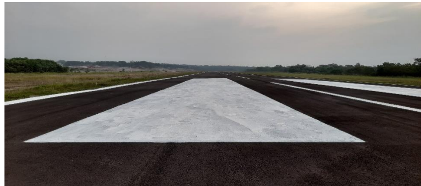
Gambar 4.19 Hasil Pengecatan Marka Aiming Point
