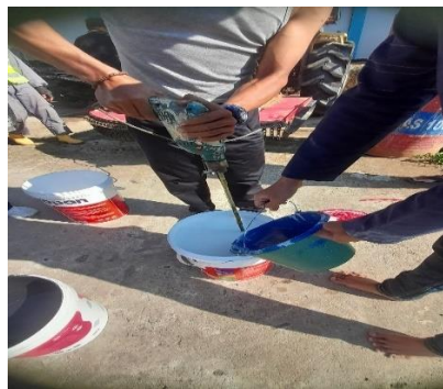
Gambar 4.17 Proses Pencampuran Cat Dengan Air
