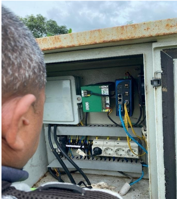
Gambar 3 . 23 Lampu indicator SWITCH sudah Menyala
