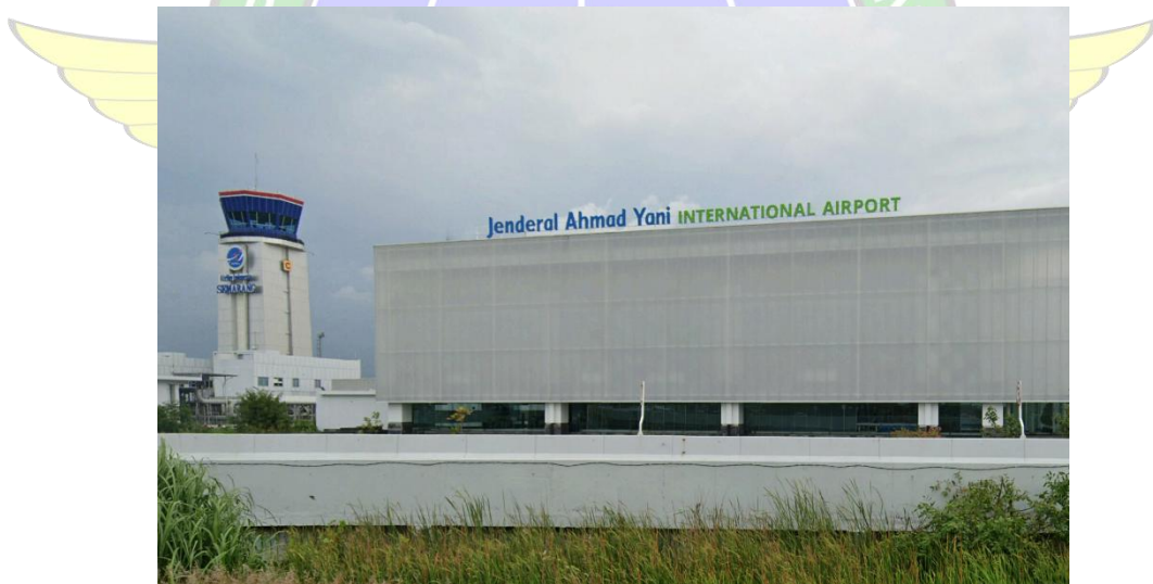
Gambar 2.1 Terminal Penumpang Bandar Udara Ahmad Yani Semarang (Sumber : Dokumentasi Penulis)
