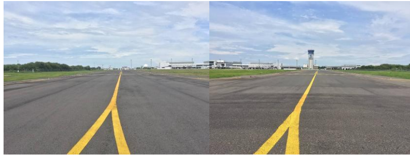
Gambar 4.4 Taxiway Golf dan Taxiway Foxtrot (Sumber : Dokumentasi Penulis)
