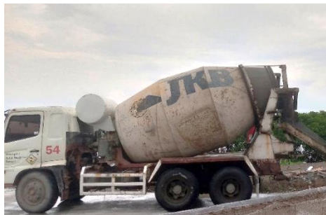
Gambar 4.31 Pencampuran Beton (Sumber : Dokumentasi Penulis)
