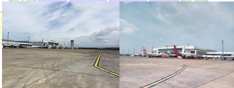
Gambar 4.5 Apron (Sumber : Dokumentasi Penulis)
