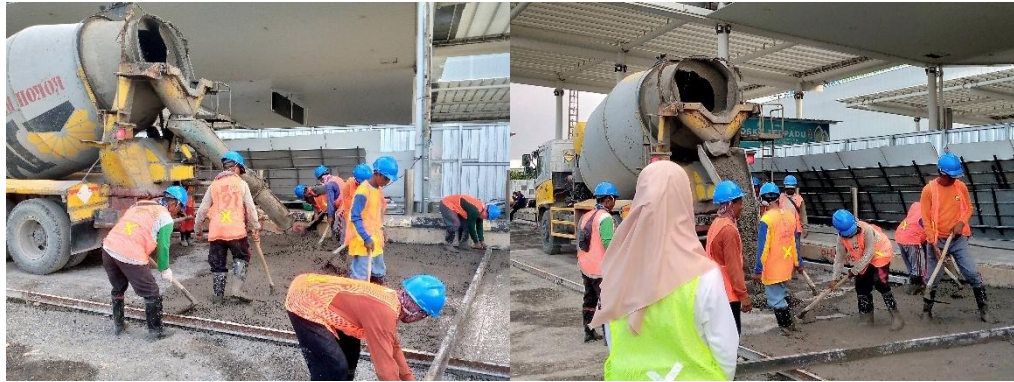
Gambar 4.33 Pengecoran Lean Concrete (Sumber : Dokumentasi Penulis)
