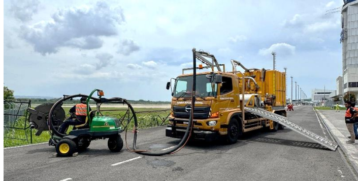
Gambar 4.14 Truk Rubber Deposit Removal dan Water Blasting Bandar Udara Internasional Juanda (Sumber : Dokumentasi Penulis)
