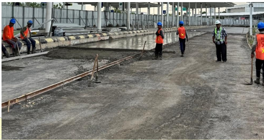
Gambar 4.32 Patok dan Bekisting (Sumber : Dokumentasi Penulis)
