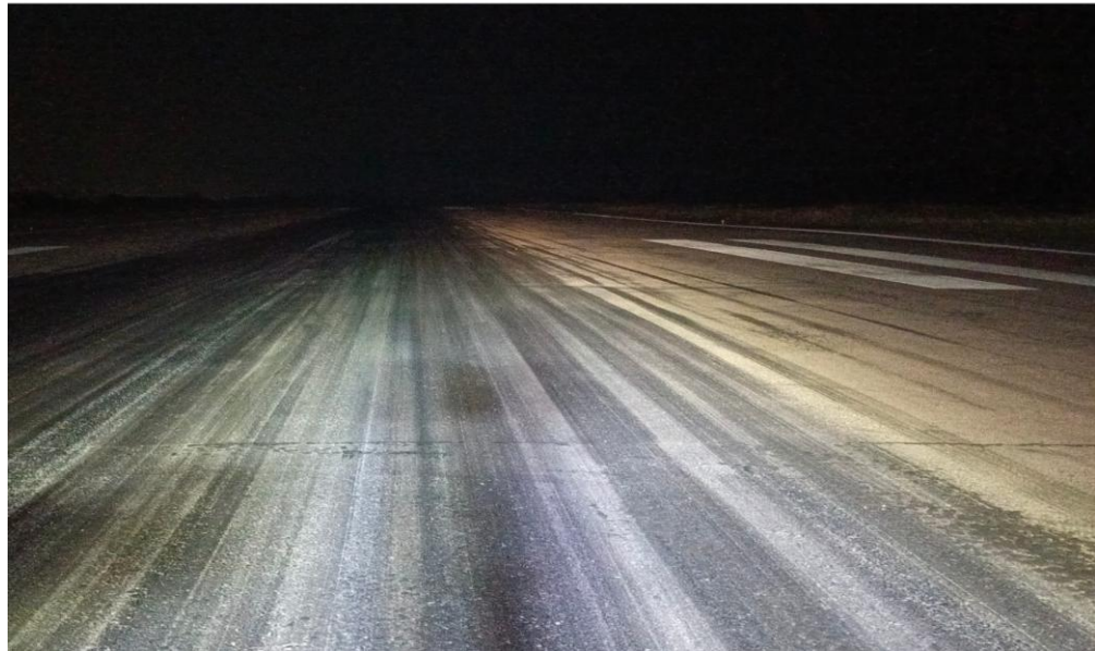
Gambar 4.11 Runway Sebelum Pembersihan Rubber Deposit (Sumber : Dokumentasi Penulis)
