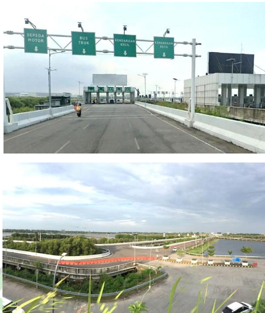
Gambar 4.6 Jalan Akses Bandara (Sumber : Dokumentasi Penulis)
