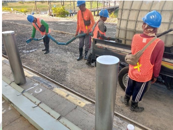
Gambar 4.30 Penyeraman Lapisan Sebelum Pengecoran (Sumber : Dokumentasi Penulis)
