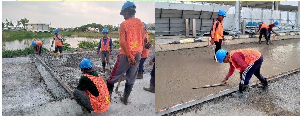
Gambar 4.34 Perataan Permukaan Lean Concrete (Sumber : Dokumentasi Penulis)
