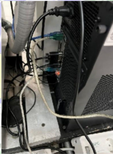
Gambar 3.57 Pemasangan kabel usb to serial pada pc Sumber : Dokumentasi Penulis 5 Desember 2024
