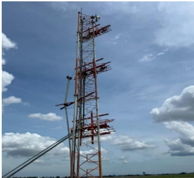
Gambar 3. 16 Antena Glide Path 25R Sumber : Dokumentasi Penulis 2024
