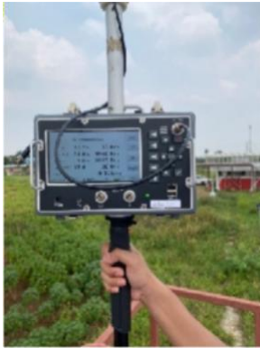
Perawatan mingguan Dan pengecekan menggunakan PIR di DVOR pasar kemis
