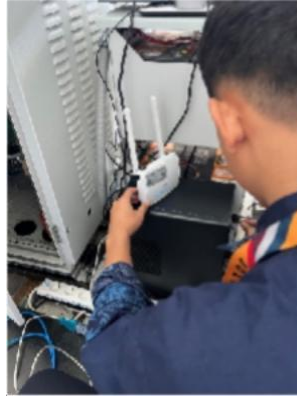
Gambar 3.58 Menghubungkan modem gsm ke pc remote Sumber : Dokumentasi Penulis 5 Desember 2024
