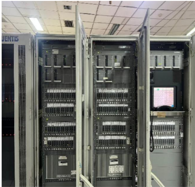
Gambar 3. 10 Kabinet VCCS Frequentis Sumber : Dokumentasi Penulis 2 Desember 2024
