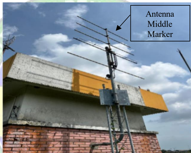
Gambar 3. 17 Antena Middle Marker 25R Sumber : Dokumentasi Penulis 2 Desember 2024
