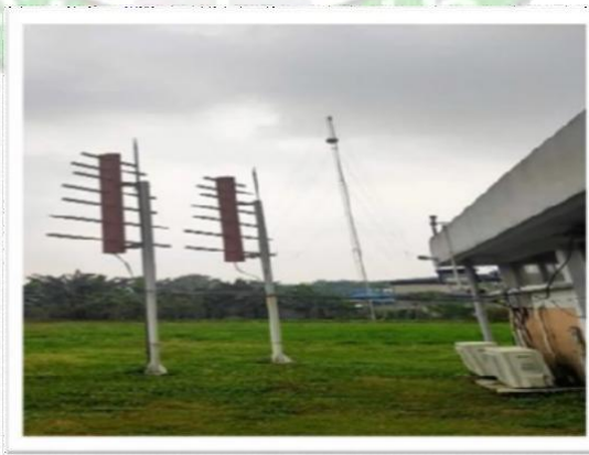
Gambar 3. 18 Antena Outter Marker 25R Sumber : Dokumentasi Penulis 2 Desember 2024
