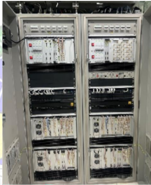
Gambar 3. 20 Kabinet Pengelolah Data RADAR PSR Sumber : Dokumentasi Penulis 8 November 2024
