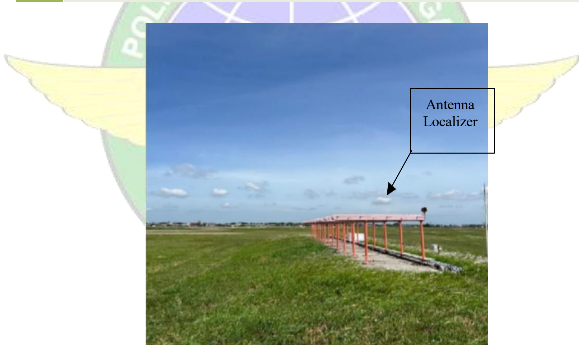
Gambar 3. 15 Antena Localizer 07L Sumber : Dokementasi Penulis 2 Desember 2024
