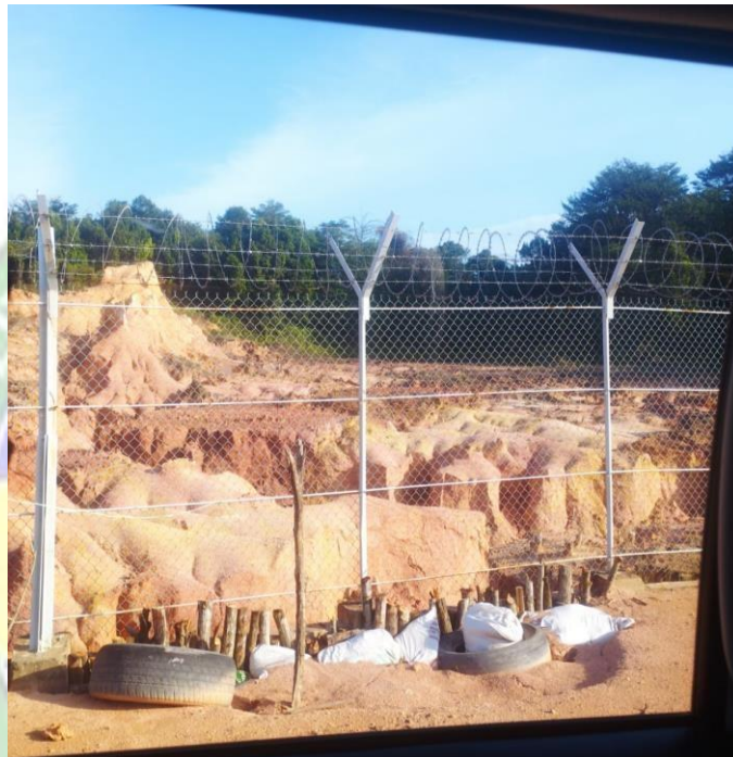
Gambar 4.5 Kondisi Parimeter tertimbun tanah atau longsor
