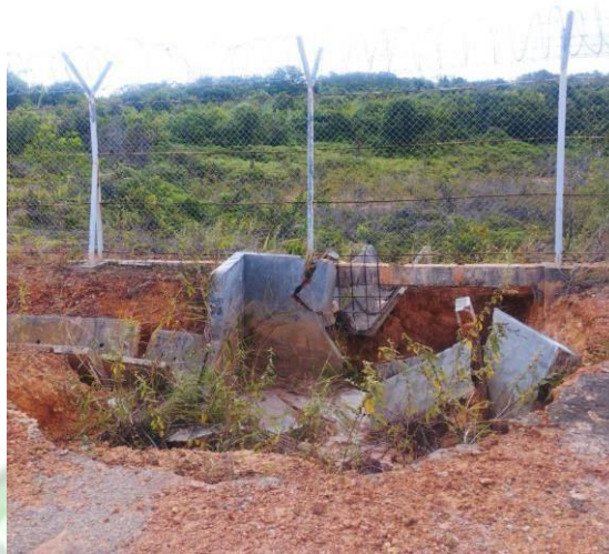
Gambar 4.6 Kondisi drainase yang rusak
