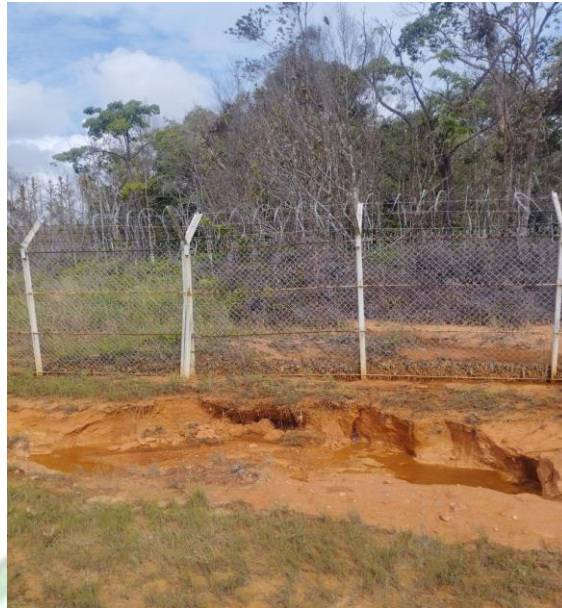
Gambar 4.7 Kondisi tanah di bawah perimeter
