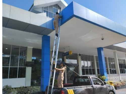
Perbaikan atap terminal keberangkatan
