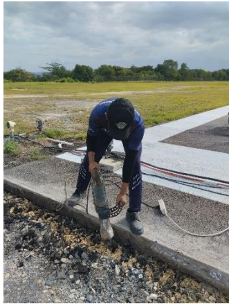
Breaker aspal di area runway 04
