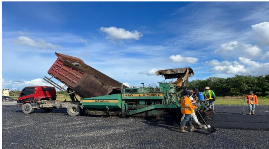
Gambar 4.35 Pekerjaan Pelapisan ulang
