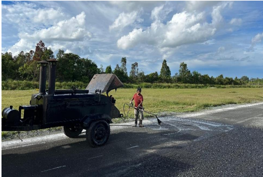
Gambar 4.34 Pekerjaan penghamparan Tack coat
