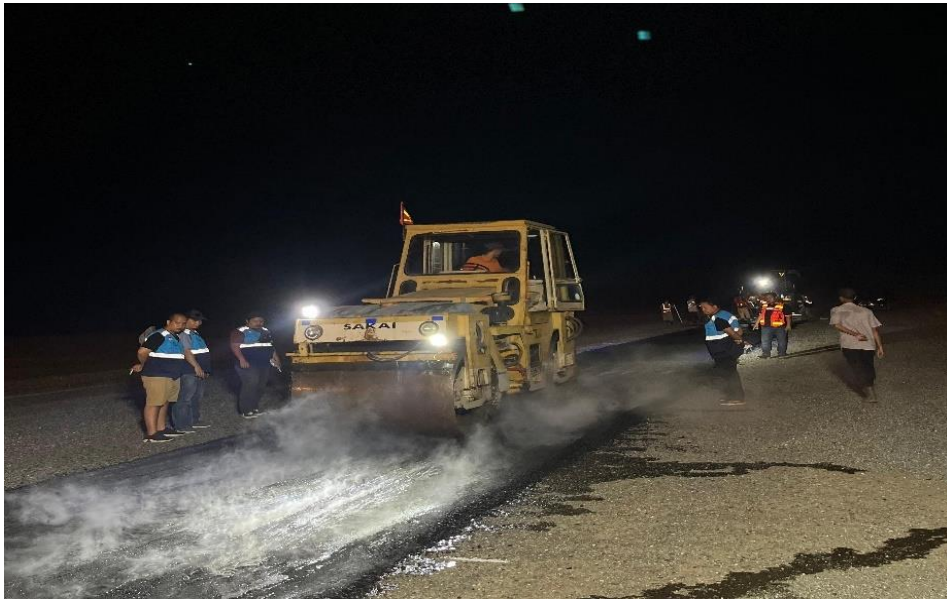
Gambar 4.36 Pekerjaan Pemadatan pertama
