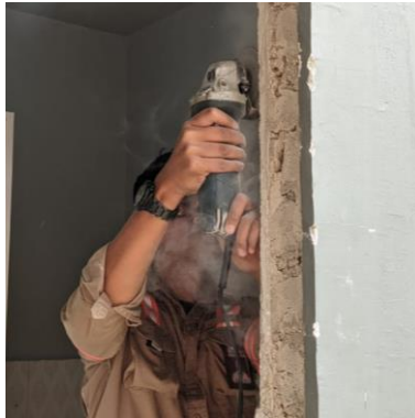
Gambar 4. 14 Cutting dinding (Sumber: Dokumentasi Penulis, 2024)
