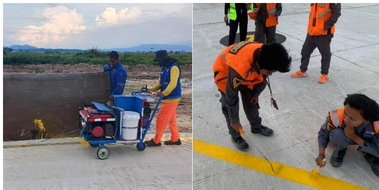
Gambar 4. 20 Pengecatan marka pada taxiway dan apron (Sumber: Dokumentasi Penulis, 2024)
