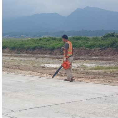
Gambar 4. 17 Pembersihan permukaan apron dan taxiway (Sumber: Dokumentasi Penulis, 2024)
