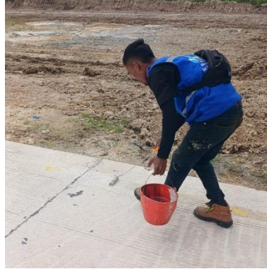
Gambar 4. 19 Pelapisan lem pada apron dan taxiway (Sumber: Dokumentasi Penulis, 2024)
