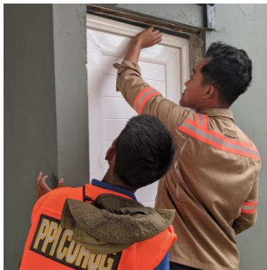
Gambar 4. 15 Pemasangan Kusen dan Pintu (Sumber: Dokumentasi Penulis, 2024)
