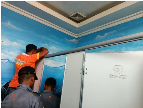
Gambar 4. 54 Memasang Penahan Atas Partisi PVC Board Sumber: Olahan Penulis, 2024
