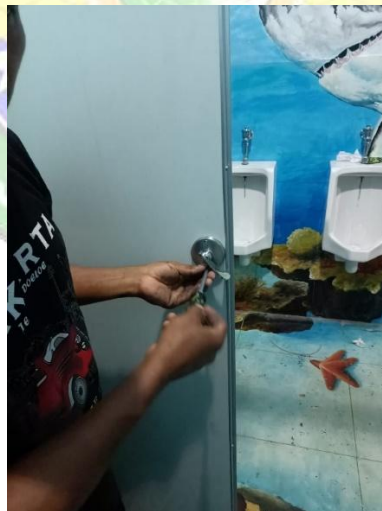
Gambar 4. 55 Memasang Slot Pintu Alloy Sumber: Olahan Penulis, 2024
