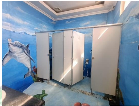
Gambar 4. 56 Kondisi Setelah Penggantian Partisi Sumber: Olahan Penulis, 2024
