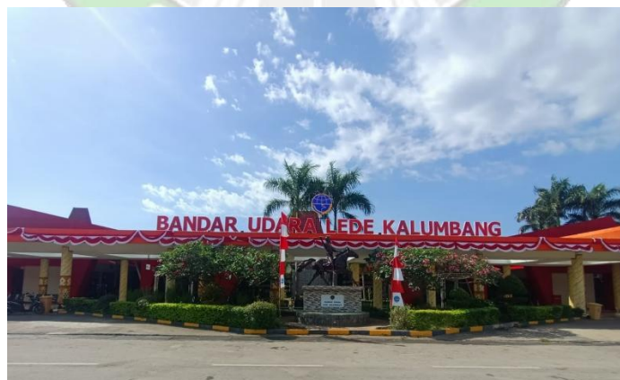
Gambar 4. 5 Terminal Penumpang Bandar Udara Lede Kalumbang Sumber: Olahan Penulis, 2024
