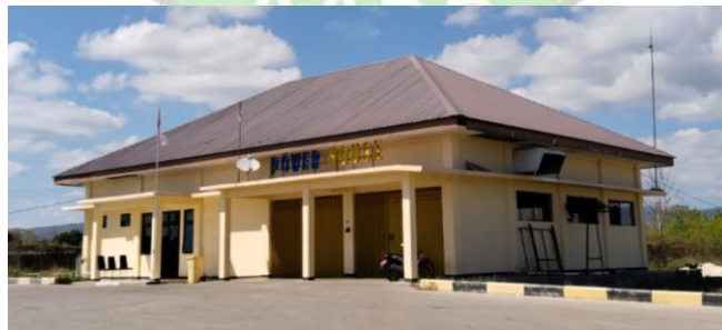
Gambar 4. 9 Gedung Power House Bandar Udara Lede Kalumbang Sumber: Olahan Penulis, 2024
