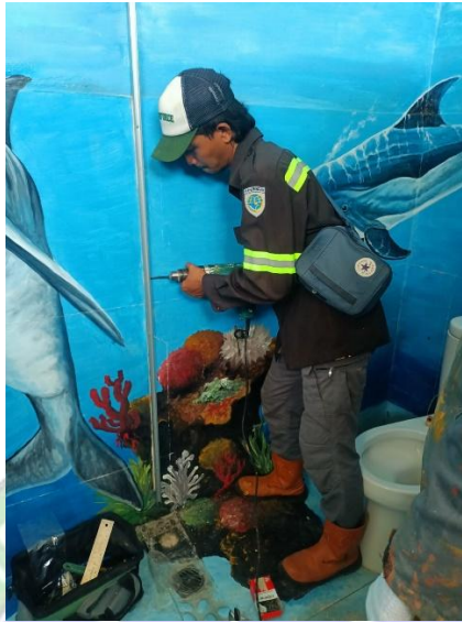
Gambar 4. 52 Memasang Rangka untuk Partisi PVC Board Sumber: Olahan Penulis, 2024
