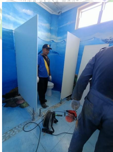
Gambar 4. 53 Memasang Partisi PVC Board Sumber: Olahan Penulis, 2024
