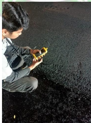
Gambar 4. 33 Pengecekan Suhu Sumber: Olahan Penulis, 2024
