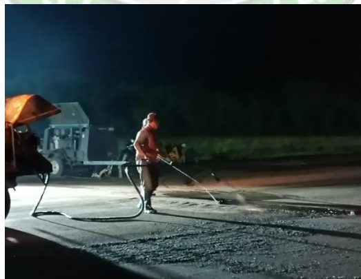
Gambar 4. 28 Penyiraman Tack Coat
