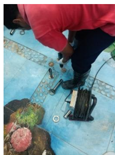
Gambar 4. 51 Memasang Kaki Cubicle Dekson Sumber: Olahan Penulis, 2024
