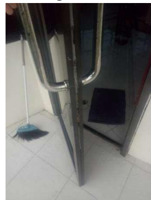
Gambar 4. 8 Celah antara pintu dan lantai ruangan tower
