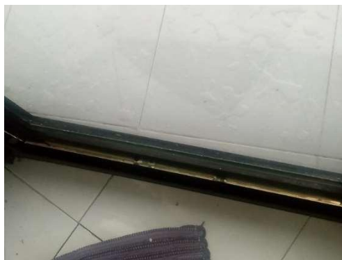
Gambar 4. 8 Celah antara pintu dan lantai ruangan tower
