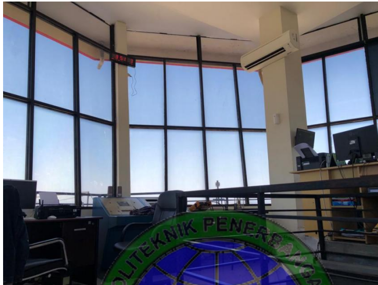
Gambar 4. 7 Lantai dan dinding belum terdapat peredam
