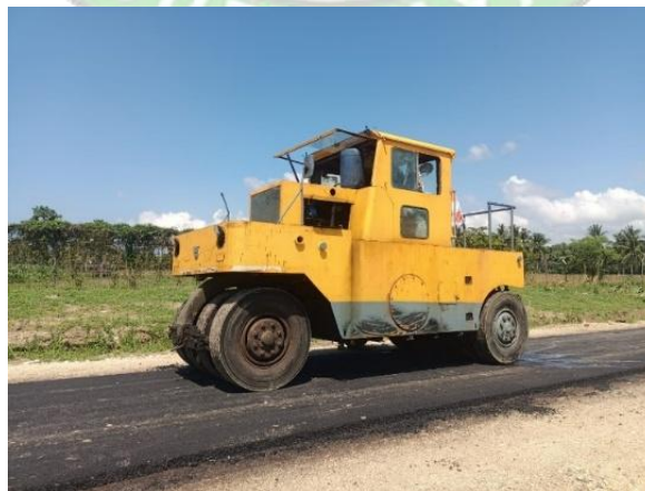
Gambar 4.34 Proses Pemadatan Akhir Sumber: Olahan Penulis, 2024
