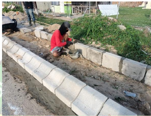
Gambar 4.52 Pekerjaan Pemasangan Kanstin Sumber: Olahan Penulis, 2024
