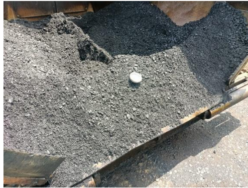
Gambar 4.29 Pengecekan Suhu Aspal Sebelum Dihampar Sumber: Olahan Penulis, 2024
