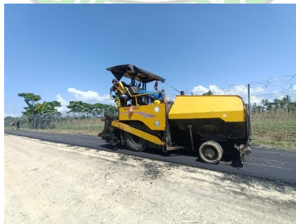
Gambar 4.15 Asphalt Finisher Sumber: Olahan Penulis, 2024
