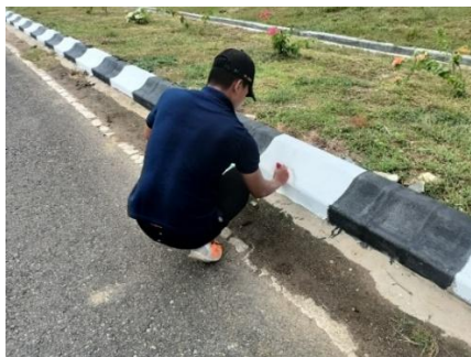
Gambar 4.58 Pengecatan Kanstin Sumber: Olahan Penulis, 2024
