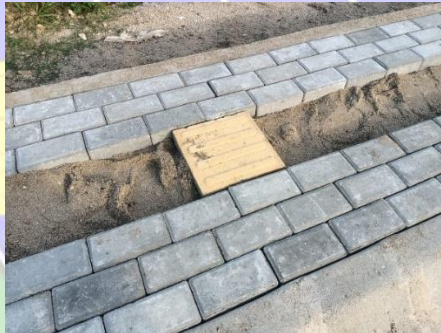
Gambar 4.57 Pekerjaan Pemasangan Guiding Block Sumber: Olahan Penulis, 2024
