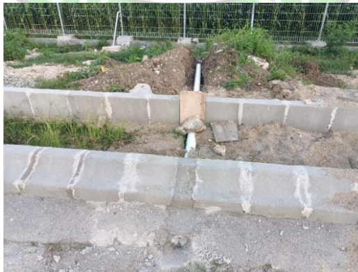
Gambar 4. 53 Pekerjaan Pemasangan Pipa PVC untuk Drainase Sumber: Olahan Penulis, 2024
