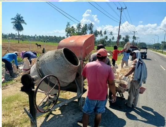
Gambar 4.50 Proses Pencampuran Agregat
