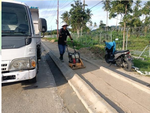
Gambar 4.55 Pemadatan Timbunan Sumber: Olahan Penulis, 2024
