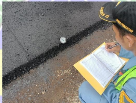
Gambar 4.32 Pengecekan Suhu Aspal Setelah Dihampar Sumber: Olahan Penulis, 2024
