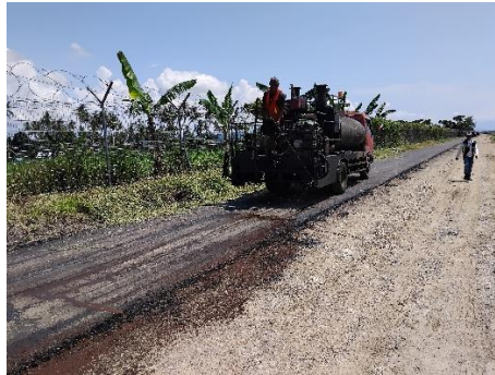
Gambar 4.27 Penyiraman Prime Coat Sumber: Olahan Penulis, 2024
