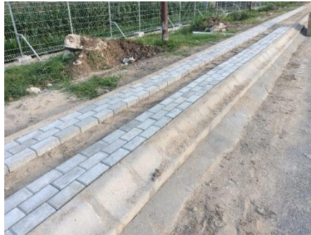
Gambar 4.56 Pekerjaan Pemasangan Paving Block Sumber: Olahan Penulis, 2024
