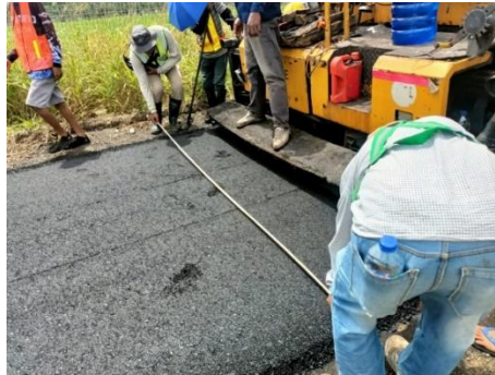
Gambar 4. 31 Pengecekan Lebar dan Ketebalan Hamparan Aspal Sumber: Olahan Penulis, 2024
