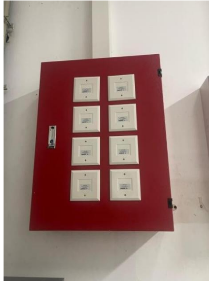
Gambar 3 . 10 Junction Box Fire Alarm Sumber : Dokumentasi Penulis 2025
