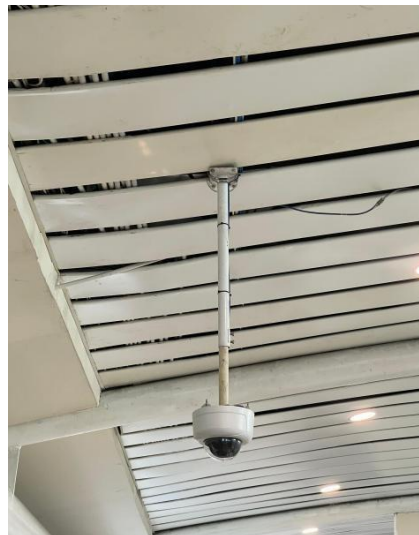
Gambar 3 . 6 Kamera CCTV PTZ (Pan, Tilt, Zoom) Sumber : Dokumentasi Penulis 2025
