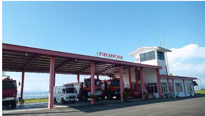
Gambar 4. 8 Gedung PKP-PK Bandar Udara Syukuran Aminuddin Amir
