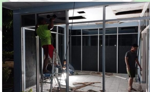
Gambar 4. 18 Pembongkaran Kaca, Pintu, Atap, dan Instalasi Listrik (Sumber: Olahan Penulis, 2024)
