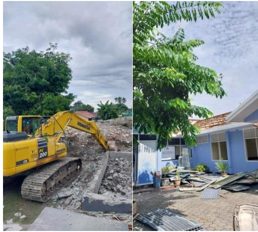
Gambar 4. 19 Pembongkaran Menggunakan Excavator
