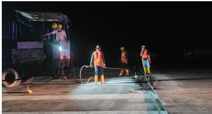
Gambar 4. 30 Penyiraman Tack Cout (Sumber: Dokumen Penulis, 2024)
