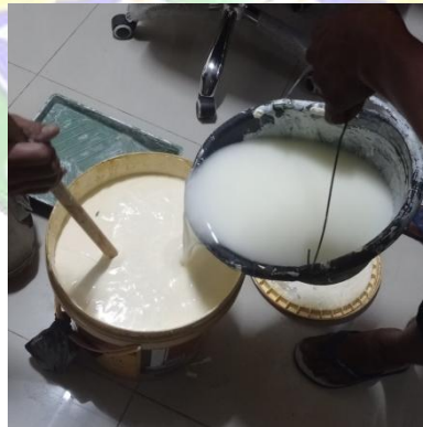
Gambar 4. 42 Pencampuran Cat dengan Air (Sumber: Dokumen Penulis, 2024)
