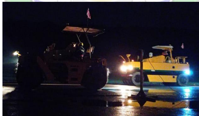
Gambar 4. 33 Pemadatan Menggunakan Pneumatic Tired Roller (Sumber: Dokumen Penulis, 2024)
