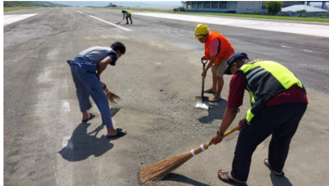
Gambar 4. 34 Pembersihan Area Pasca Overlay (Sumber: Dokumen Penulis, 2024)
