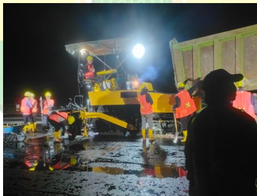
Gambar 4. 31 Penghamparan Asphalt (Sumber: Dokumen Penulis, 2024)
