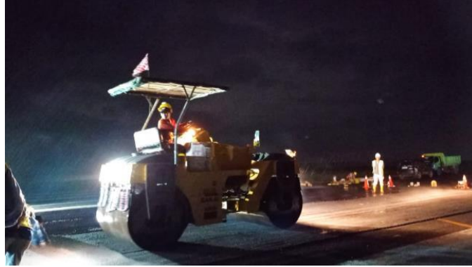
Gambar 4. 32 Pemadatan Menggunakan Tandem Roller (Sumber: Dokumen Penulis, 2024)
