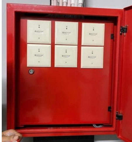
Gambar 3. 12 Junction Box Fire Alarm Sumber: Dokumentasi Penulis (2025)
