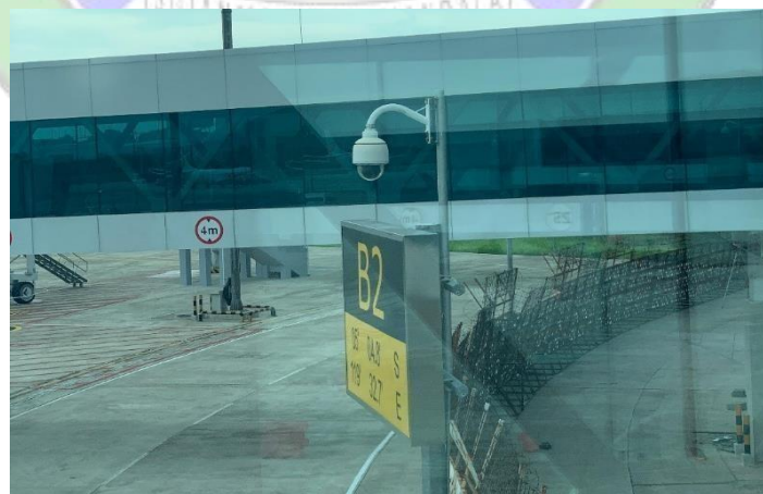
Gambar 3. 7 Kamera CCTV PTZ (Pan, Tilt, Zoom) Sumber : Dokumentasi Penulis (2025)
