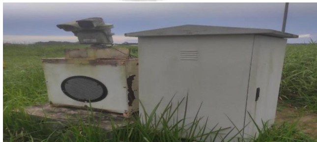
Gambar 3. 14 Bird deterrent Sumber : Dokumentasi Penulis (2025)
