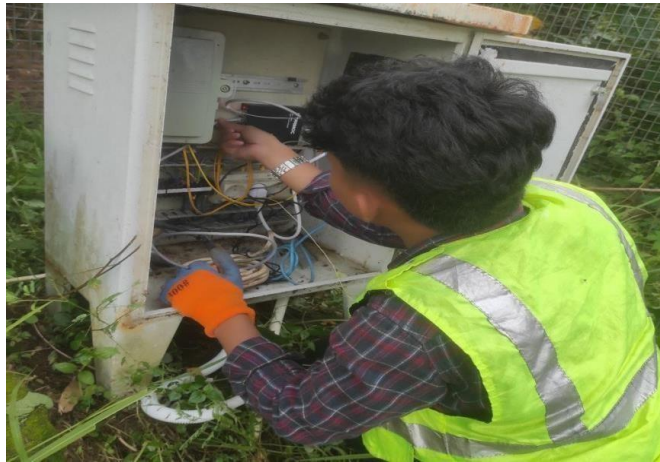
Gambar 3. 22 melakukan koneksi dari switch cctv dengan mini PC Sumber : Dokumentasi penulis (2025)
