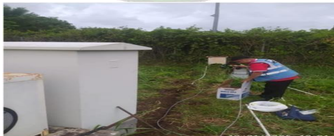
Gambar 3. 19 melakukan pengukuran panjang kabel Sumber : Dokumentasi penulis (2025)
