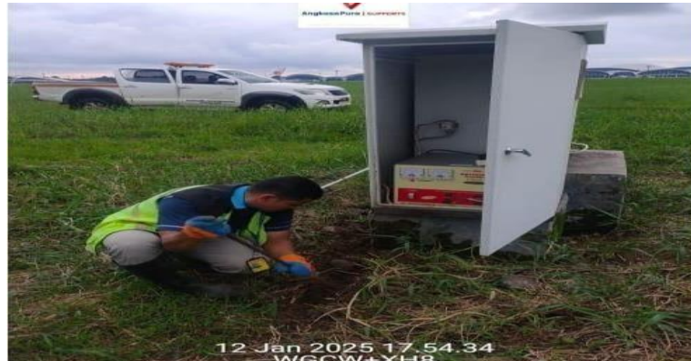
Gambar 3. 20 Menggali tanah buat jalur kabel Sumber : Dokumentasi penulis (2025)
