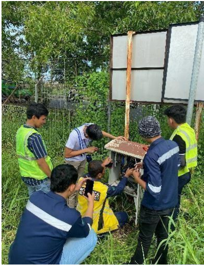
Melakukan Pengecekan Tegangan Output PS
