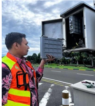
Gambar 3. 46 47 Memasang shrink protections pada kabel FO, kabel power, dan kabel RF (Sumber : Dokumentasi Penulis)
