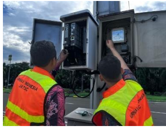
Gambar 3. 43 Melepas shrink protections yang melekat pada kabel FO, kabel power, dan kabel RF (Sumber : Dokumentasi Penulis)
