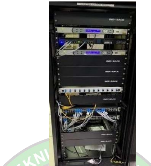
Gambar 3. 13 Server NTP Master Clock (Sumber : Dokumentasi Penulis)
