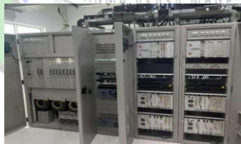
Gambar 3. 19 Kabinet Pengolah Data RADAR PSR
