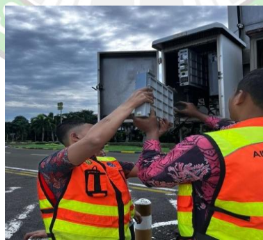
Gambar 3. 47 Merekatkan shrink protections yang terdapat pada kabel FO, kabel power, dan kabel RF (Sumber : Dokumentasi Penulis)
