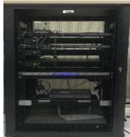
Gambar 3. 40 Server CPDLC (Sumber : Dokumentasi Penulis)
