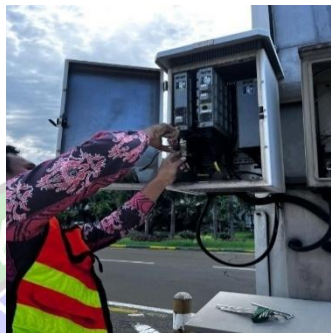
Gambar 3. 44 Melepas pada kabel FO, kabel power, dan kabel RF dari antenna yang masih tersambung pada modul R07 (Sumber : Dokumentasi Penulis)
