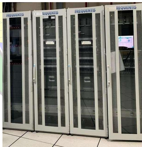
Gambar 3. 9 Kabinet VCCS Frequentis (Sumber : Dokumentasi Penulis)
