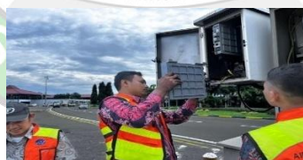
Gambar 3. 45 Melepas kabel FO yang masih tersambung dan melepas beberapa baut yang terpasang di Modul Receiver GS 27 Tipe R07 yang lama (Sumber : Dokumentasi Penulis)
