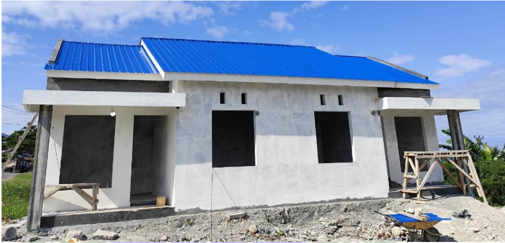
Gambar 4. 28 Hasil akhir pembangunan (Sumber: Dokumentasi Penulis,Tahun 2024)
