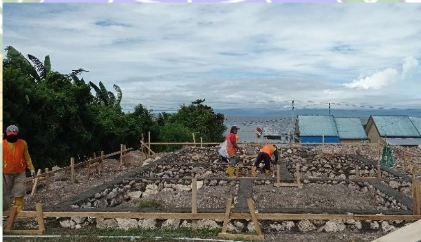
Gambar 4. 20 Pemasangan pondasi batu kali (Sumber: Dokumentasi Penulis,Tahun 2024)
