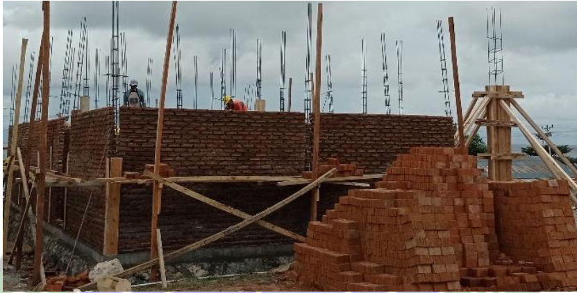
Gambar 4. 21 Pemasangan bata dan plesteran (Sumber: Dokumentasi Penulis,Tahun 2024)
