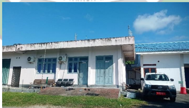
Gambar 4. 5 Power House (Sumber: Dokumentasi Penulis, Tahun 2024)
