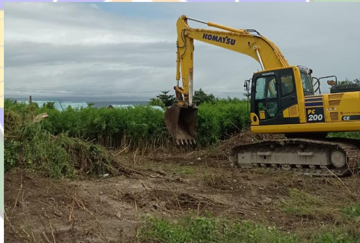
Gambar 4. 17 Pembersihan lokasi (Sumber: Dokumentasi Penulis, Tahun 2024)
