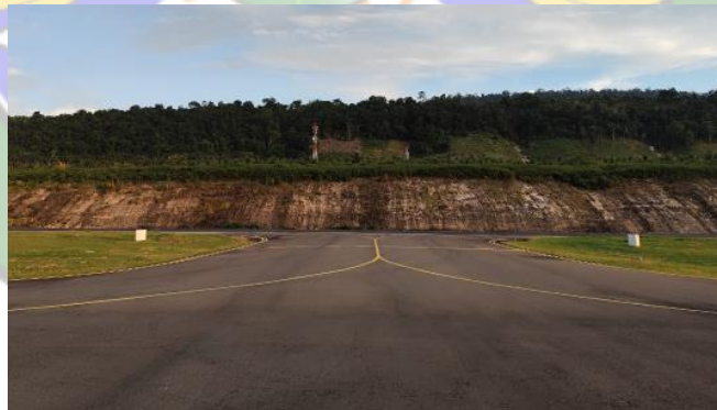
Gambar 4. 9 Taxiway A (Sumber: Dokumentasi Penulis,Tahun 2024)
