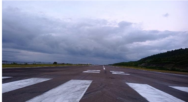
Gambar 4. 8 Runway (Sumber: Dokumentasi Penulis,Tahun 2024)
