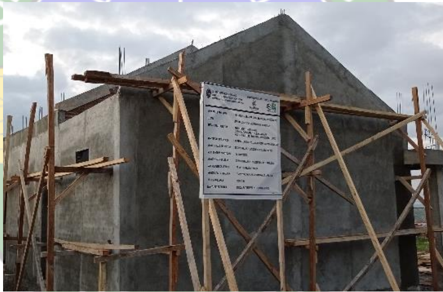
Gambar 4. 22 Pembuatan struktur beton (Sumber: Dokumentasi Penulis, Tahun 2024)
