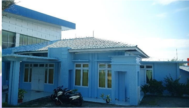
Gambar 4. 4 Kantor Administrasi (Sumber: Dokumentasi Penulis, Tahun 2024)
