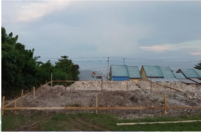
Gambar 4. 18 Pengukuran dan pemasangan bouwplank (Sumber: Dokumentasi Penulis,Tahun 2024)
