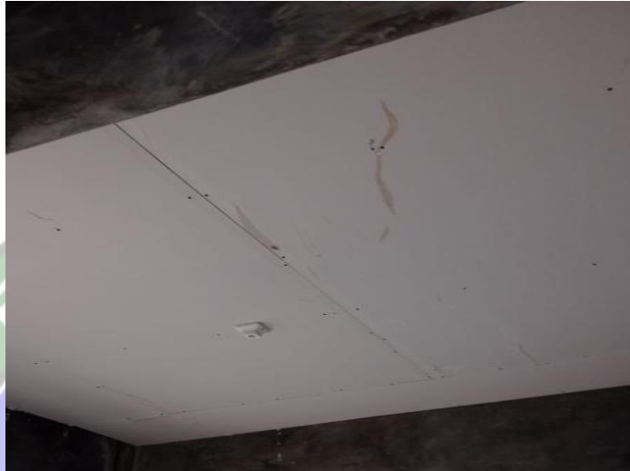
Gambar 4. 26 Pemasangan plafon (Sumber: Dokumentasi Penulis,Tahun 2024)
