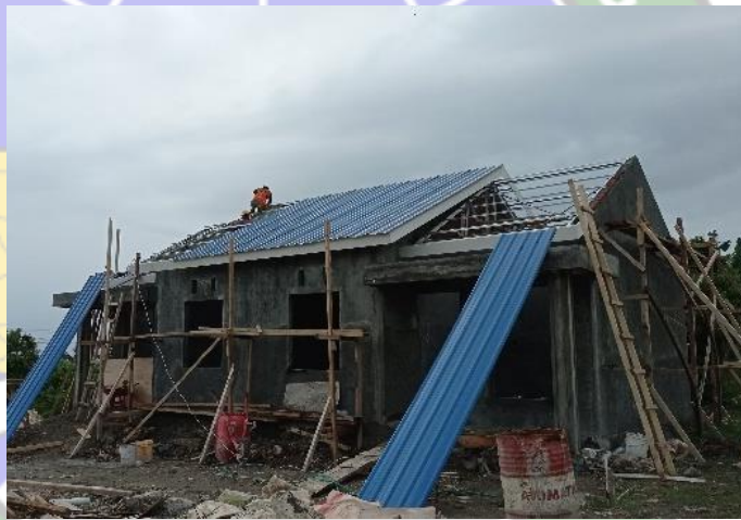
Gambar 4. 25 Pemasangan atap (Sumber: Dokumentasi Penulis,Tahun 2024)
