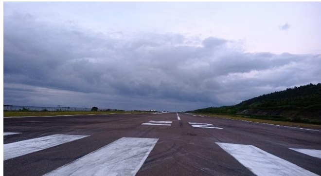
Gambar 4. 8 Runway (Sumber: Dokumentasi Penulis, Tahun 2024)
