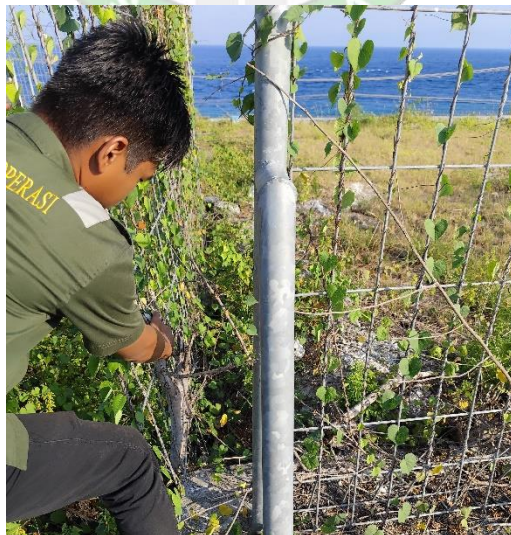
Gambar 4. 19 Perbaikan pagar perimeter yang rusak
