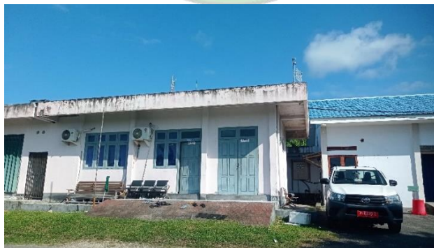
Gambar 4. 5 Power House (Sumber: Dokumentasi Penulis, Tahun 2024)
