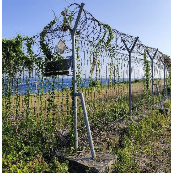
Gambar 4. 20 Hasil dari perbaikan pagar menggunakan kawat besi
