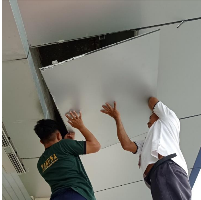
Gambar 4. 26 Pemasangan plafon PVC
