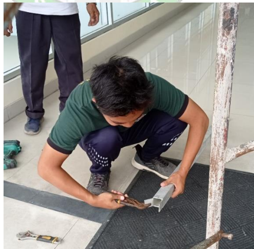
Gambar 4. 24 Pemotongan kerangka
