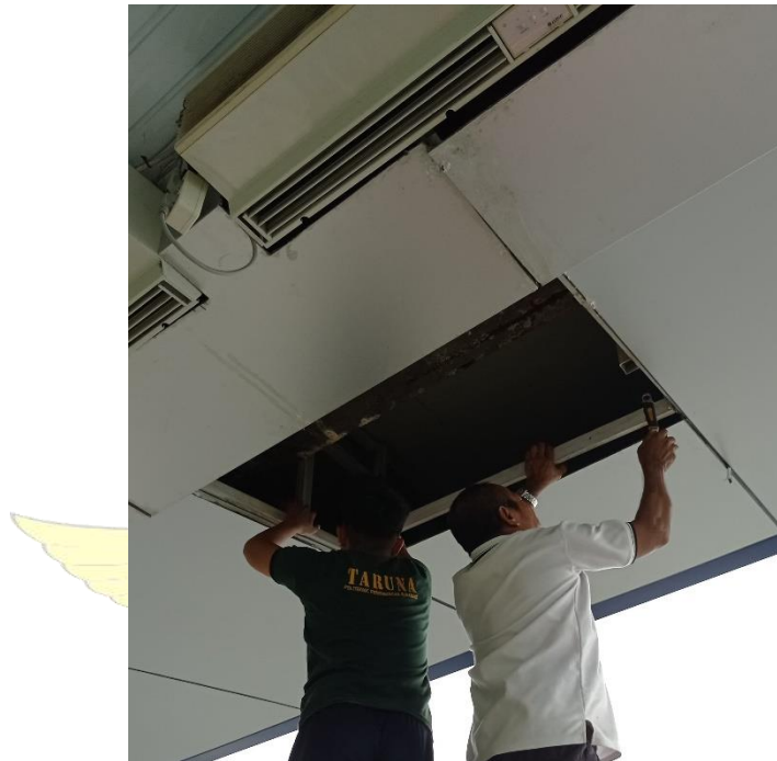
Gambar 4. 25 Pemasangan kerangka plafon
