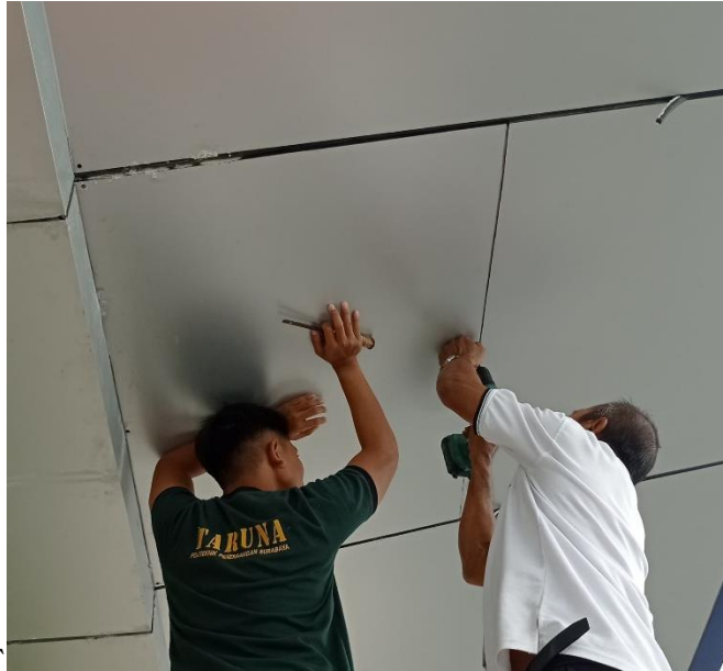
Gambar 4. 27 Pengecekan sambungan plafon (Sumber: Dokumentasi Penulis, Tahun 2024)
