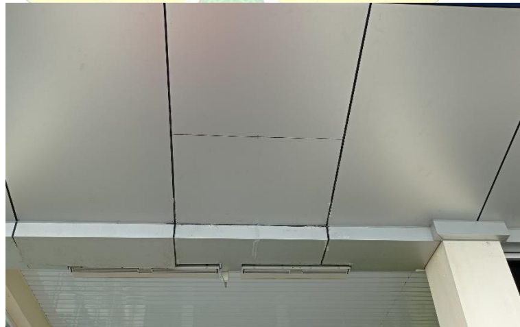
Gambar 4. 28 Hasil akhir pemasangan plafon (Sumber: Dokumentasi Penulis, Tahun 2024)
