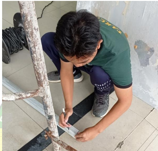
Gambar 4. 23 Pengukuran kerangka besi hollow
