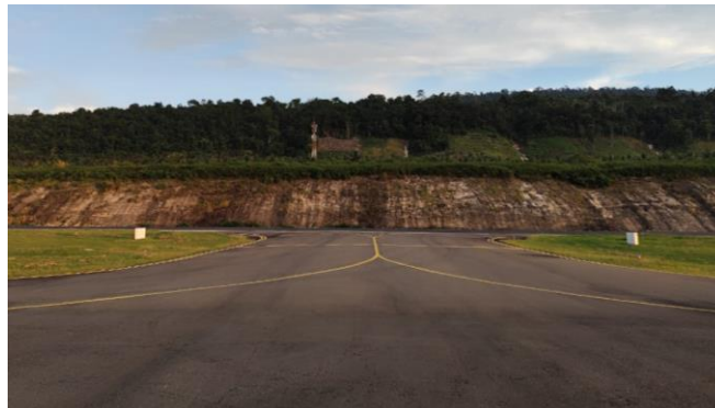
Gambar 4. 9 Taxiway A (Sumber: Dokumentasi Penulis, Tahun 2024)
