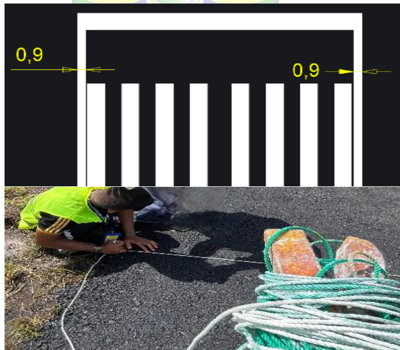
Gambar 4. 15 Dimensi dan gambar pembuatan Runway side stripe marking ( Sumber : Dokumentasi Penulis, 2024 )
