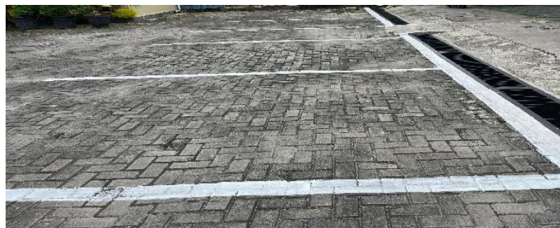
Gambar 4. 26 Gambar Hasil Perawatan Kanstin dan Marka Parkir ( Sumber : Dokumentasi Penulis, 2024 )
