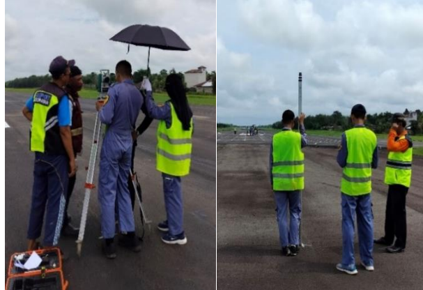
Gambar 4. 14 Gambar proses penentuan titik tengah Runway ( Sumber : Dokumentasi Penulis, 2024 )
