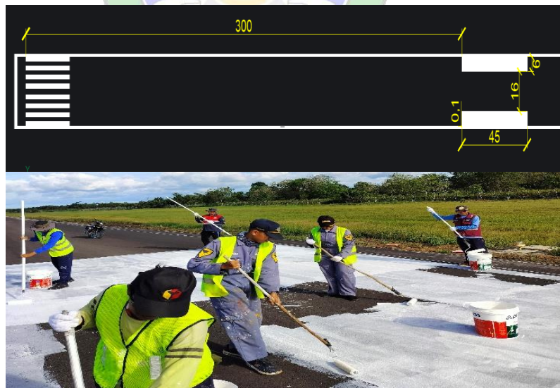
Gambar 4. 19 Dimensi dan gambar pembuatan Aiming Point marking ( Sumber : Dokumentasi Penulis, 2024 )
