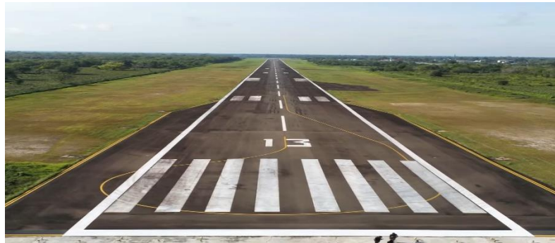
Gambar 4. 22 Gambar Hasil Pembuatan Marka Runway ( Sumber : Dokumentasi Humas Bandara, 2024 )
