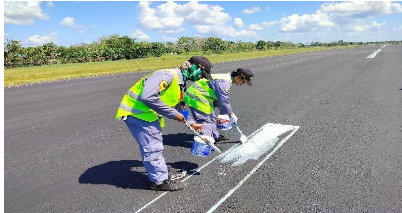
Gambar 4. 18 Dimensi dan gambar pembuatan centre line ( Sumber : Dokumentasi Penulis, 2024 )
