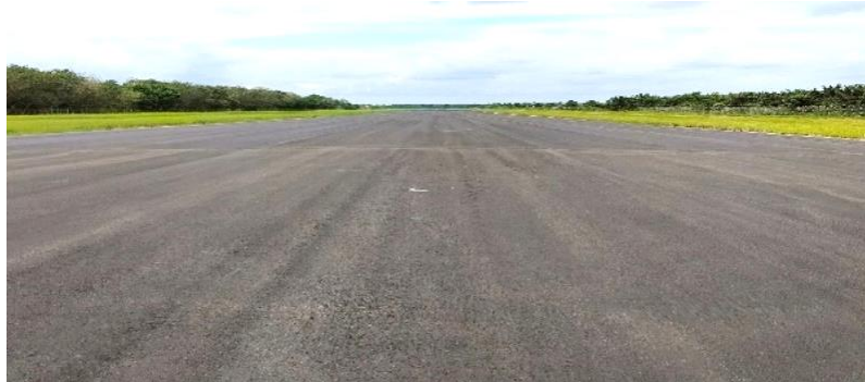
Gambar 4. 10 Gambar Runway tanpa marka ( Sumber : Dokumentasi Penulis, 2024 )
