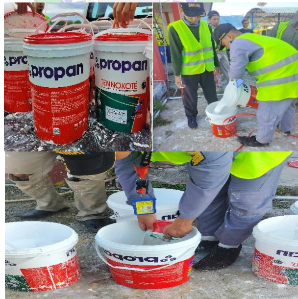
Gambar 4. 13 Gambar cat dan proses pencampurannya ( Sumber : Dokumentasi Penulis, 2024 )
