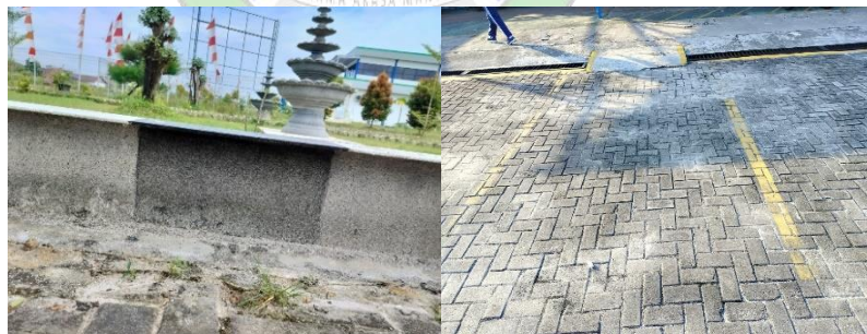
Gambar 4. 11 Gambar Kanstin dan Marka Parkir yang tidak terawat ( Sumber : Dokumentasi Penulis, 2024 )
