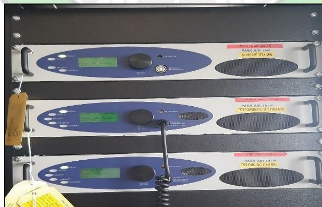
Gambar 3. 4 VHF Park Air System Sumber: Dokumentasi Penulis
