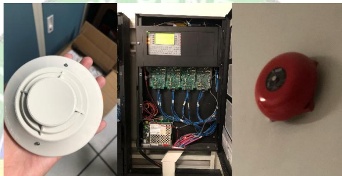
Gambar 3.12 Fire Alarm Sumber: Dokumentasi Penulis
