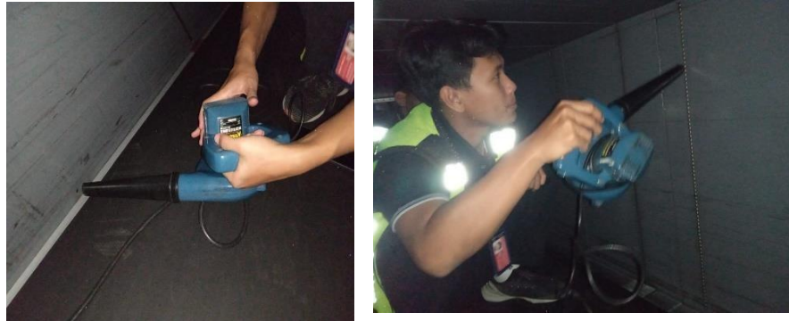
Gambar 4 3 Pembersihan Sensor X – Ray
