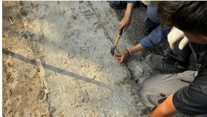
Gambar 4. 97 Pembuatan Bekisting Jembatan
