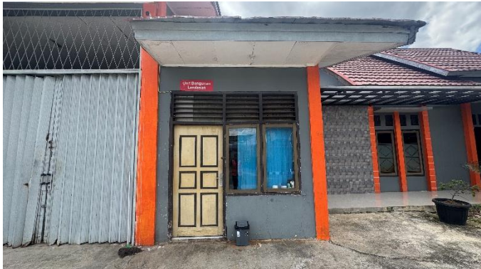
Gambar 4. 14 Gedung Bangunan dan Landasan
