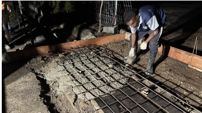
Gambar 4. 104 Perataan Beton
