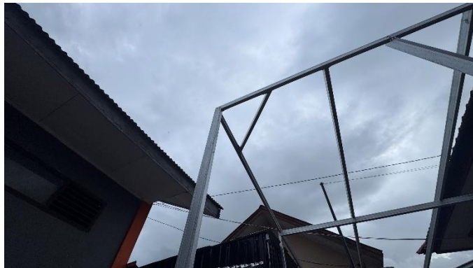
Gambar 4. 141 Pemasangan Rangka Atap
