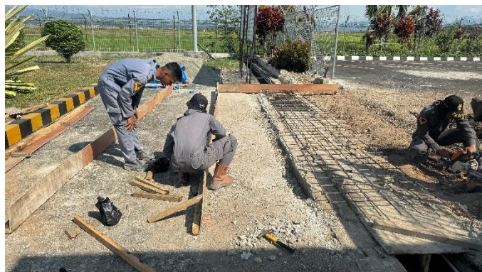
Gambar 4. 98 Pembuatan Bekisting Jalan Akses Sisi Udara
