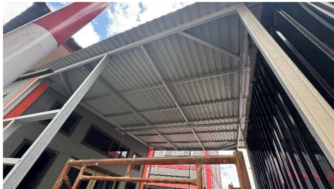
Gambar 4. 144 Pemasangan Spandek
