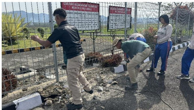
Gambar 4. 93 Pembongkaran Sloof Beton
