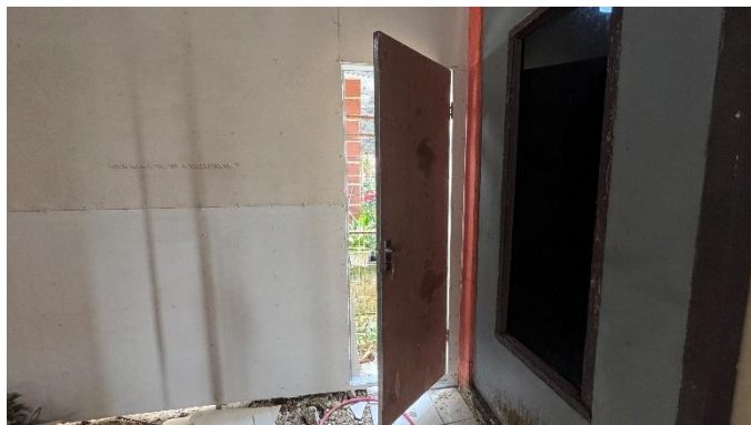
Gambar 4. 148 Pemasangan Pintu Bangunan
