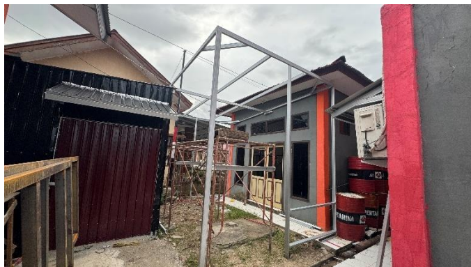
Gambar 4. 142 Pemasangan Rangka Atap
