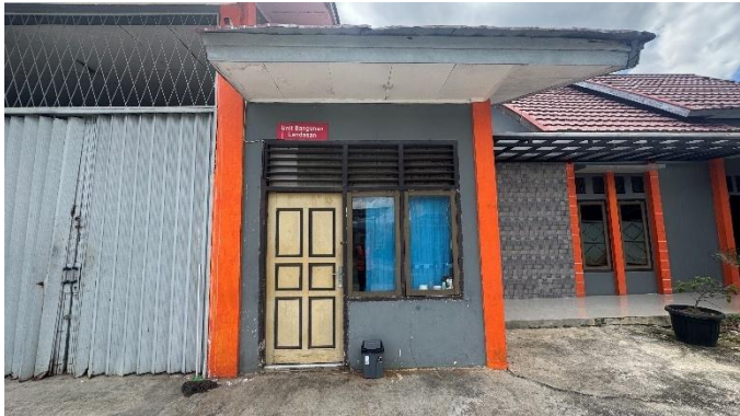
Gambar 3. 24 Gedung Bangunan dan Landasan
