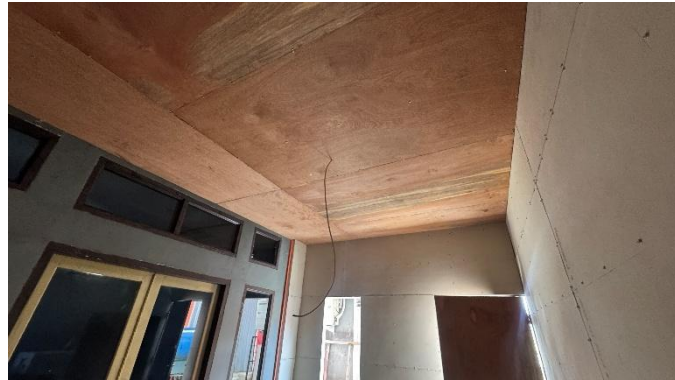
Gambar 4. 151 Pemasangan Atap Bangunan
