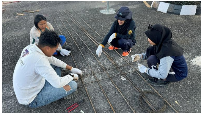
Gambar 4. 100 Pembuatan Wiremesh
