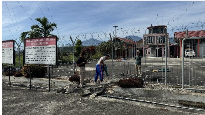
Gambar 4. 91 Pembongkaran Pagar Parimeter Sisi Udara
