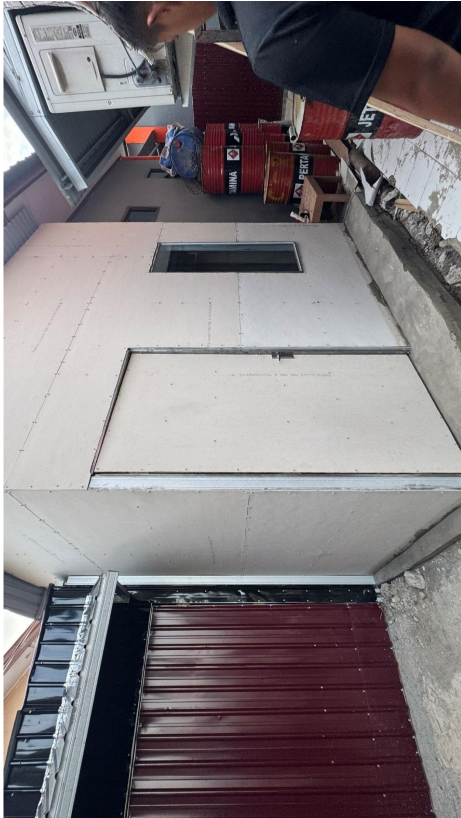
Lampiran 21 Landscape Sebelum Pekerjaan Pembuatan Ruang CCR
