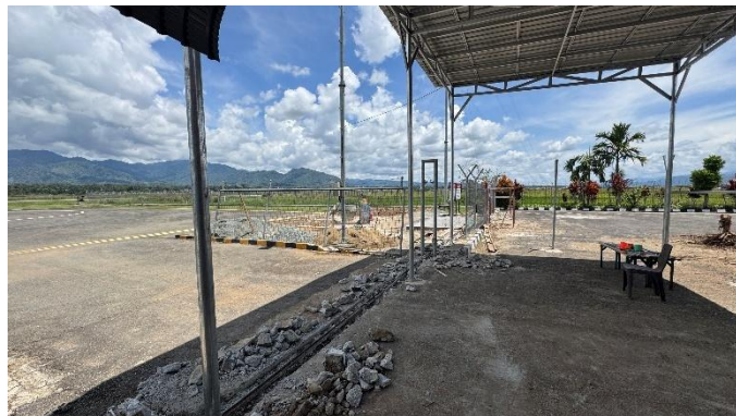
Gambar 4. 92 Pembongkaran Pagar Sliding Sisi Udara
