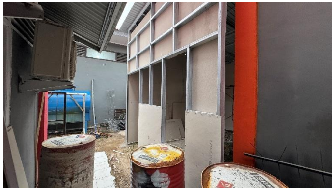
Gambar 4. 150 Pemasangan Dinding GRC
