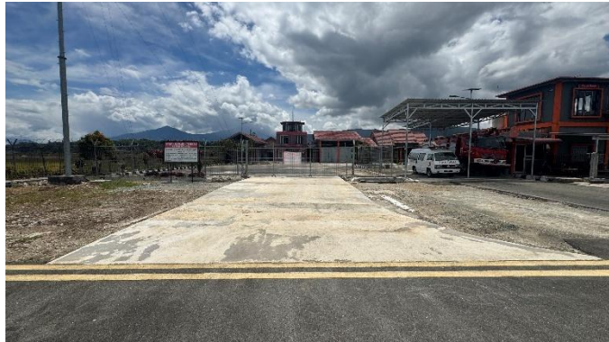
Gambar 3. 39 Jalan Akses Masuk Airside
