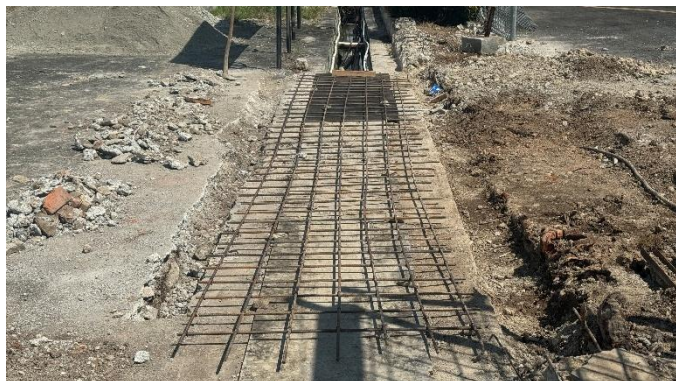
Gambar 4. 101 Pemasangan Wiremesh
