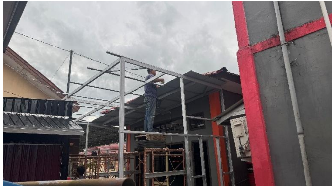
Gambar 4. 143 Pemasangan Rangka Atap
