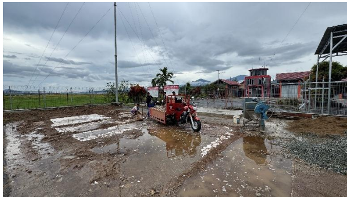
Gambar 4. 95 Pembersihan Sisa Pembongkaran Taman
