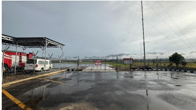
Gambar 4. 42 Jalan Akses Sisi Udara Setelah Pekerjaan
