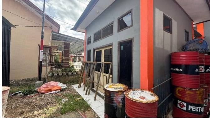
Gambar 4. 136 Pemberishan Lokasi Pekerjaan
