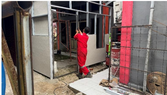
Gambar 4. 147 Pemasangan Rangka Pintu dan Jendela
