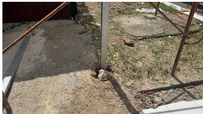
Gambar 4. 137 Pembuatan Pondasi Bangunan
