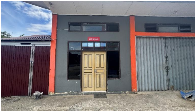
Gambar 3. 25 Kantor Unit Listrik
