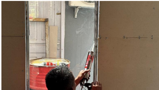
Gambar 4. 156 Pemasangan Kaca dan Pemberian Silicon
