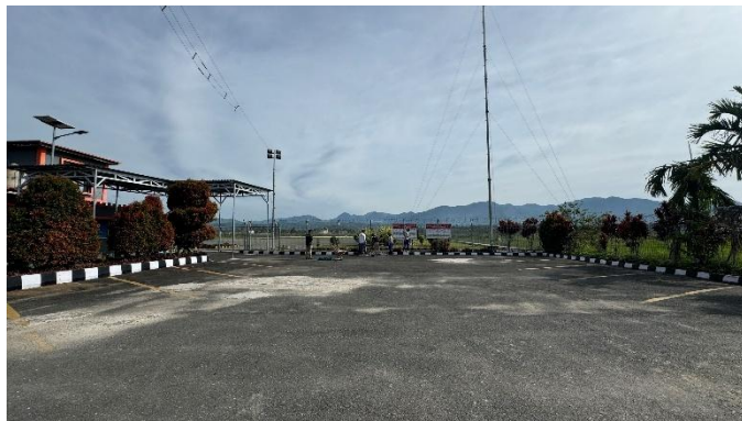
Gambar 4. 40 Jalan Akses Sisi Udara Sebelum Dibongkar
