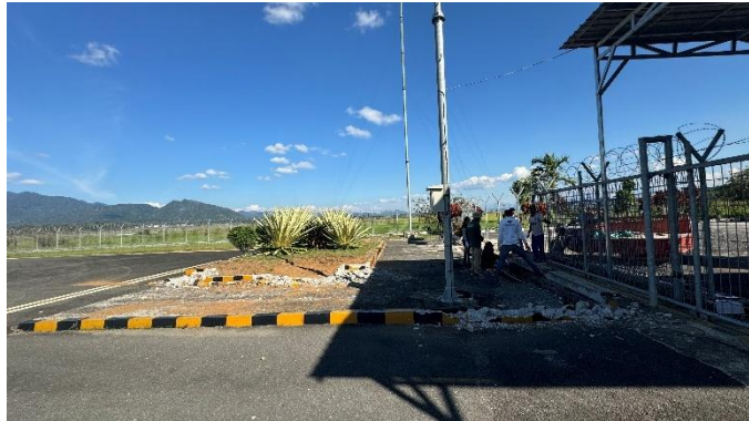
Gambar 4. 94 Pembongkaran Taman Sisi Udara
