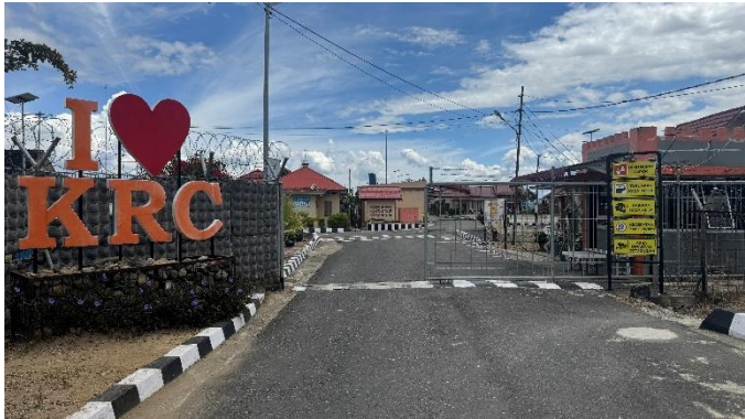
Gambar 4. 26 Jalan Masuk Bandara
