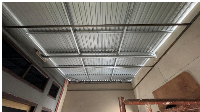
Gambar 4. 145 Pemasangan Spandek
