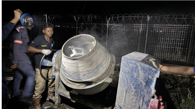
Gambar 4. 102 Pengadukan Beton
