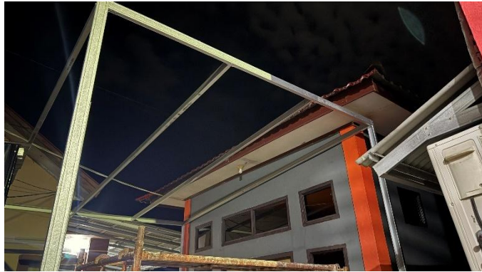
Gambar 4. 140 Pemasangan Rangka Atap
