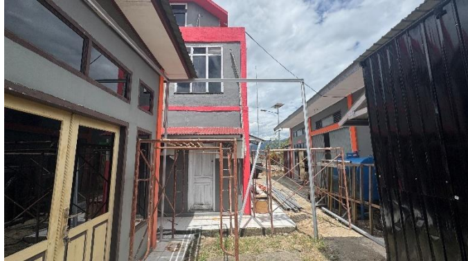
Gambar 4. 138 Pemasangan Rangka Dinding
