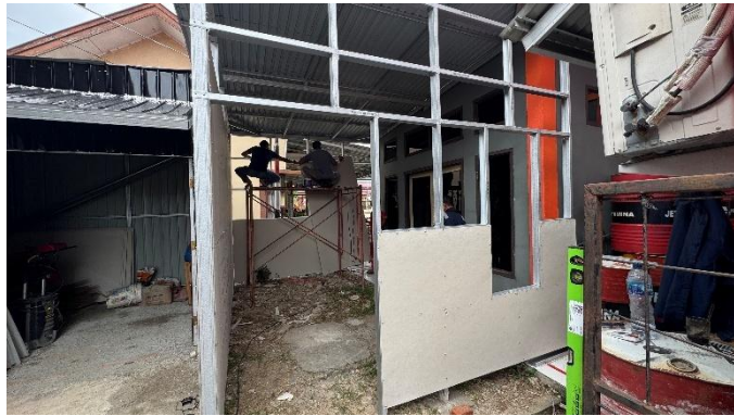
Gambar 4. 149 Pemasangan Dinding GRC
