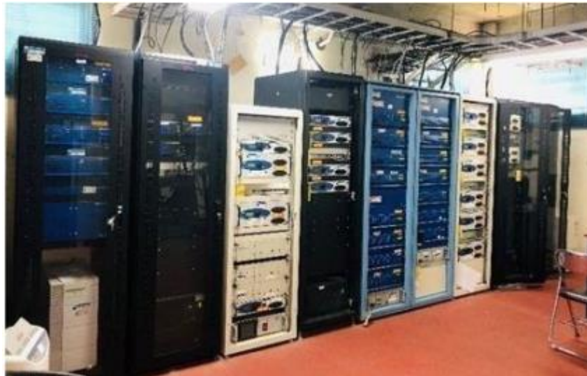
Gambar 3. 7 Radio Transmitter VHF A/G Sumber: Dokumentasi Penulis
