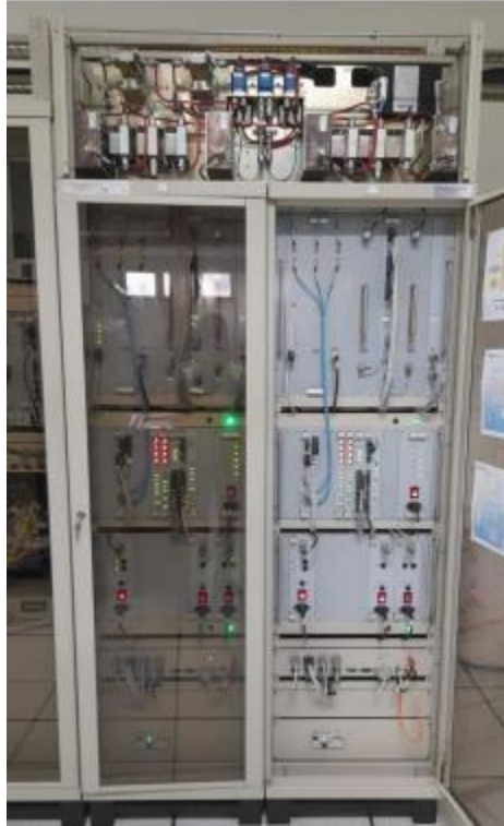
Gambar 3. 14 Rak Radar MSSR Merk ELDIS Sumber: Dokumentasi Penulis
