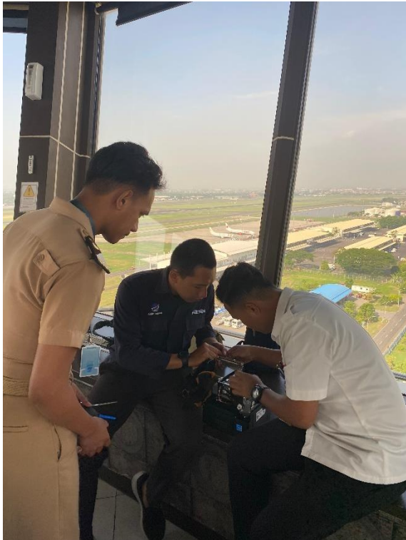
Melakukan Perbaikan Strip Print di Gedung Tower
