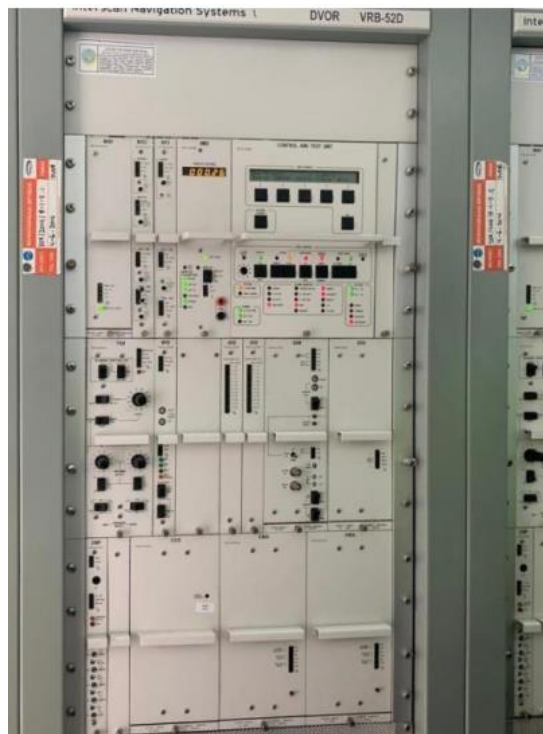
Gambar 3. 11 Transmitter DVOR Merk InterScan Sumber: Dokumentasi Penulis
