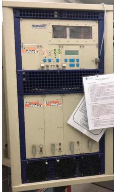
Gambar 3. 8 Localizer Merk Normarc Sumber: Dokumentasi Penulis
