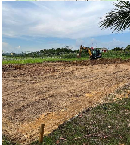
Gambar 4. 39 excavator mengerjakan stripping tanah
