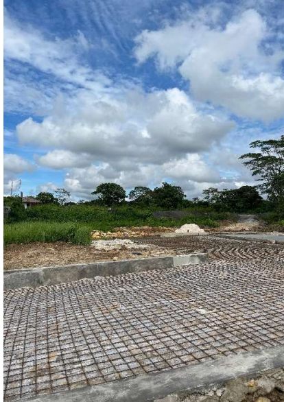
Gambar 4. 45 peletakkan tulangan untuk beton
