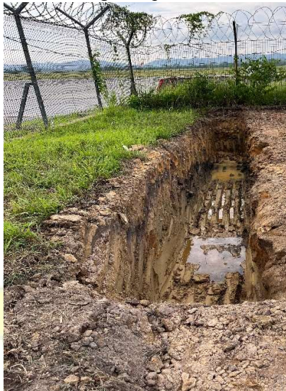
Gambar 4. 42 galian pondasi untuk ramp
