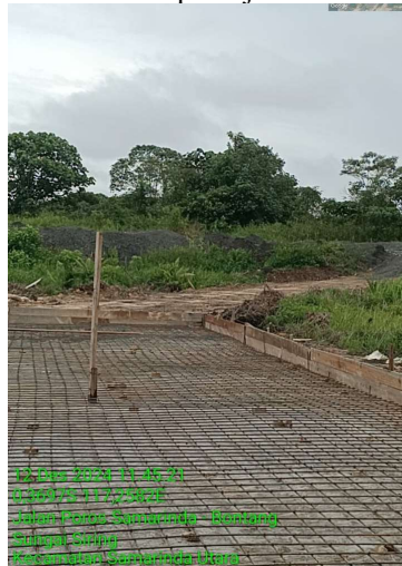
Gambar 4. 46 pekerjaan bekisting
