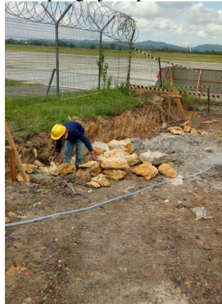
Gambar 4. 43 pengerjaan pondasi untuk Ramp
