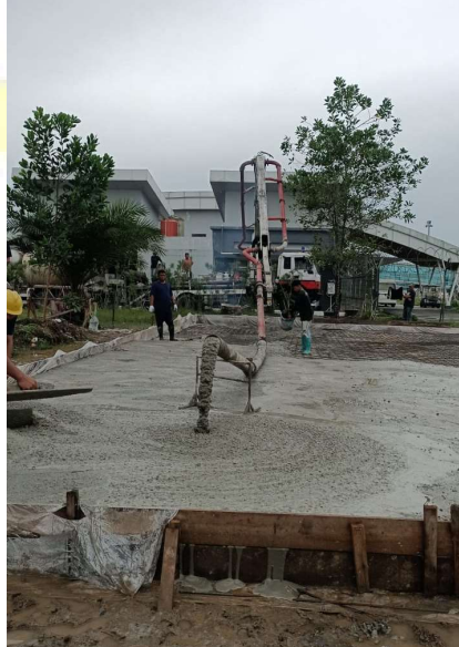
Gambar 4. 47 Pengecoran menggunakan Concrete pump
