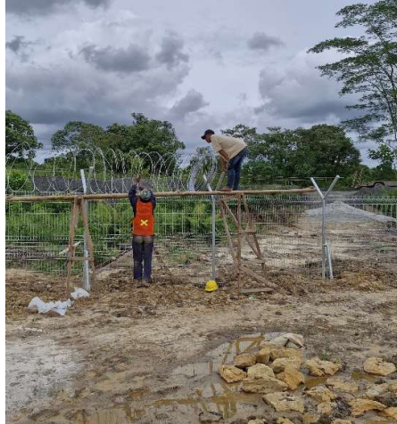
Gambar 4. 49 pekerjaan pemasangan pagar parimeter
