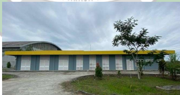
Gambar 4. 12 Gedung Power House (Sumber : Dokumentasi Penulis, 2024)
