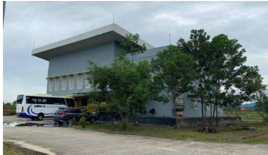
Gambar 4. 16 Gedung A2B (Sumber : Dokumentasi Penulis, 2024)
