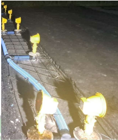
Gambar 4. 21 Proses Pemasangan Tulangan (Sumber : Dokumentasi Penulis, 2024)
