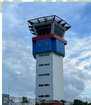
Gambar 4. 7 Bangunan Pengatur Lalu Lintas(ATC Tower)
