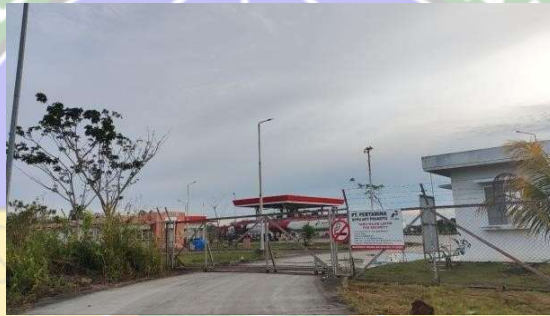
Gambar 4. 11 Depot Pengisian Bahan Bakar Pesawat Udara (Sumber : Dokumentasi Penulis, 2024)
