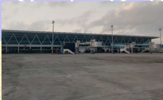
Gambar 4. 3 Apron (Sumber : Dokumentasi Penulis, 2024)
