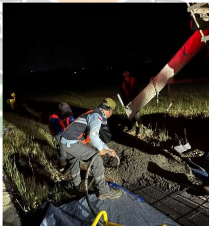
Gambar 4. 22 Proses Penghamparan Beton (Sumber : Dokumentasi Penulis, 2024)
