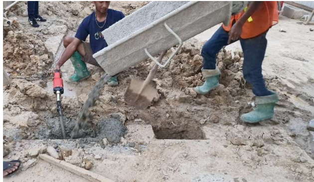
Gambar 4. 26 Penuangan Beton pada Lubang Fondasi (Sumber : Dokumentasi Penulis, 2024)
