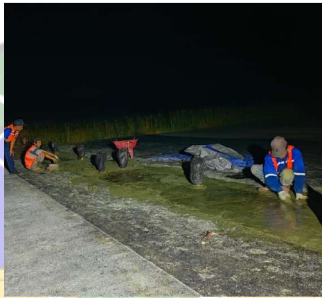
Gambar 4. 23 Proses Finishing Beton (Sumber : Dokumentasi Penulis, 2024)
