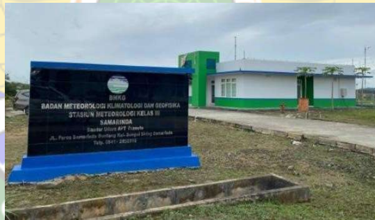
Gambar 4. 9 Bangunan Meteorologi (BMKG) (Sumber : Dokumentasi Penulis, 2024)
