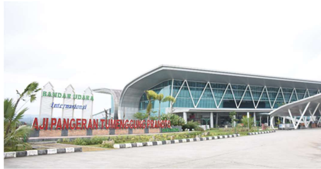
Gambar 4. 4 Gedung Terminal Bandara Aji Pangeran Tumenggung Pranoto (Sumber : Dokumentasi Penulis, 2024)
