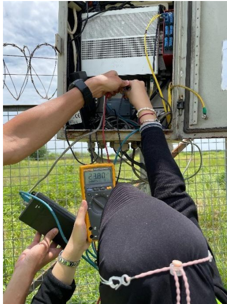
Gambar 3. 23 Memastikan power supply kamera dalam kondisi normal 24 volt
