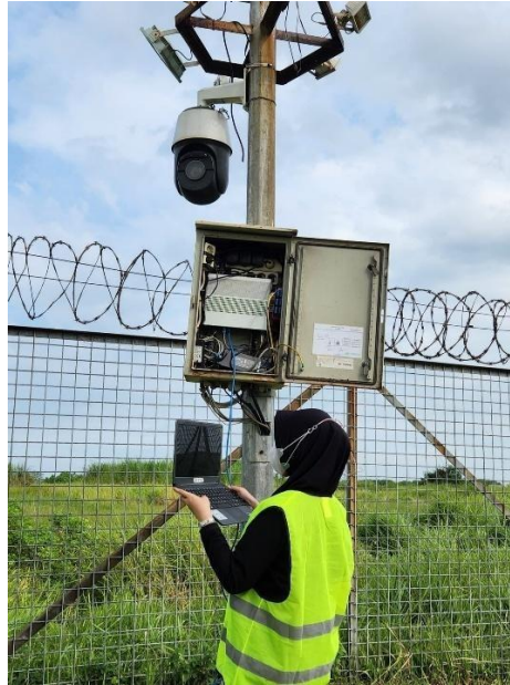
Gambar 3. 21 Melakukan pengecekan status radar menggunakan laptop untuk menampilkan status radar di web Navtech
