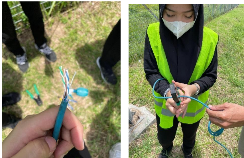
Gambar 3. 24 Melakukan penggantian RJ45
