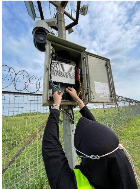
Gambar 3. 25 Menyambungkan RJ45 ke switch
