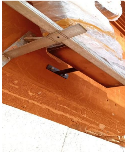
Gambar 4. 15 Dokumentasi setelah Pembuatan dan mengencangkan paku dynabolt (sumber : Dokumentasi pribadi, 2024)
