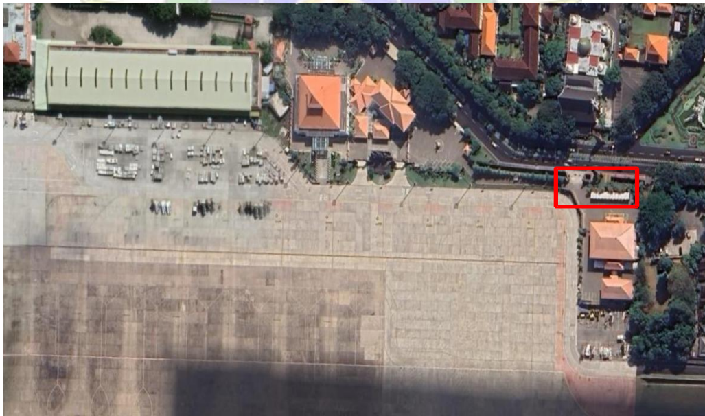
Gambar 4. 18 Lokasi pagar yang korosi atau berkarat
