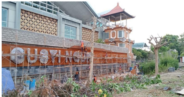
Gambar 4. 10 Dokumentasi proses Pembuatan Papan Nama Bandara
