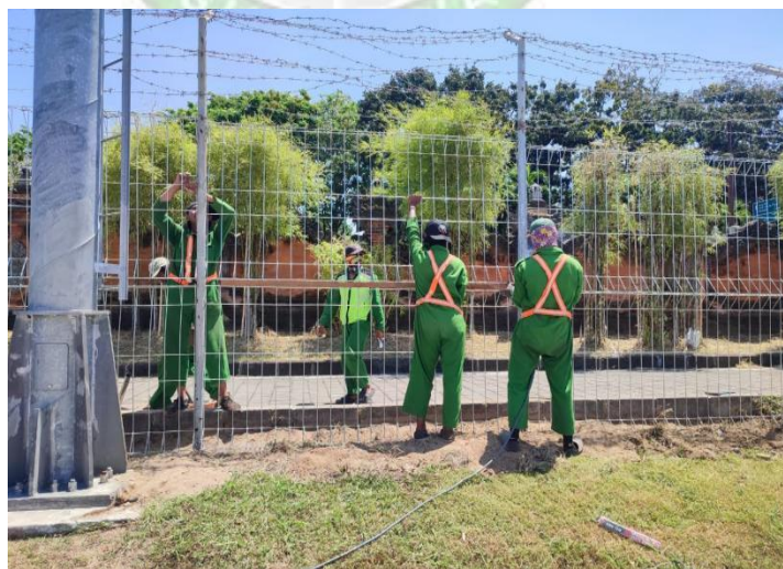
Gambar 4. 19 Perbaikan pagar perimeter
