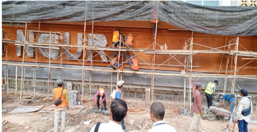
Gambar 4. 11 Dokumentasi proses pengukuran jarak tiap Papan Nama Bandara (sumber : Dokumentasi pribadi, 2024)
