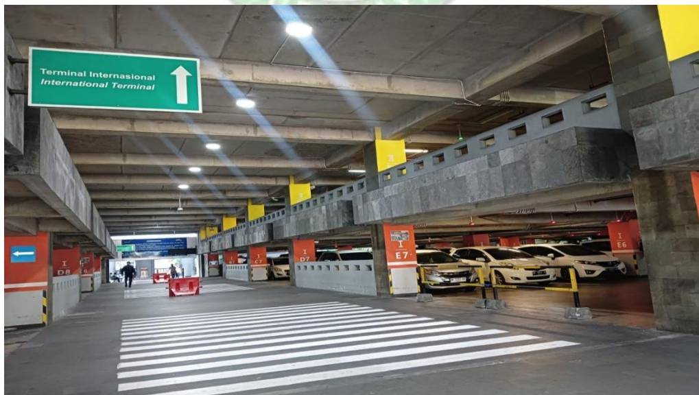
Gambar 4. 5 Parking Area ( Sumber : Dokumentasi Pribadi, 2025)
