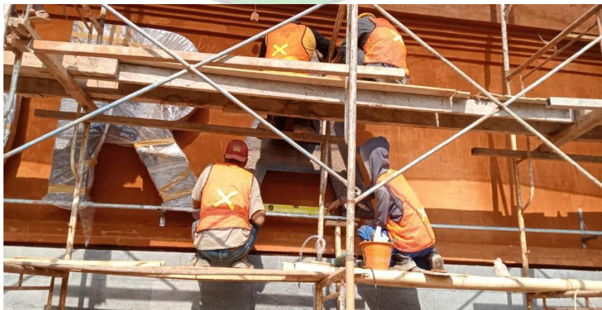
Gambar 4. 12 Dokumentasi proses menyeimbangkan Papan Nama Bandara (sumber : Dokumentasi pribadi, 2024)
