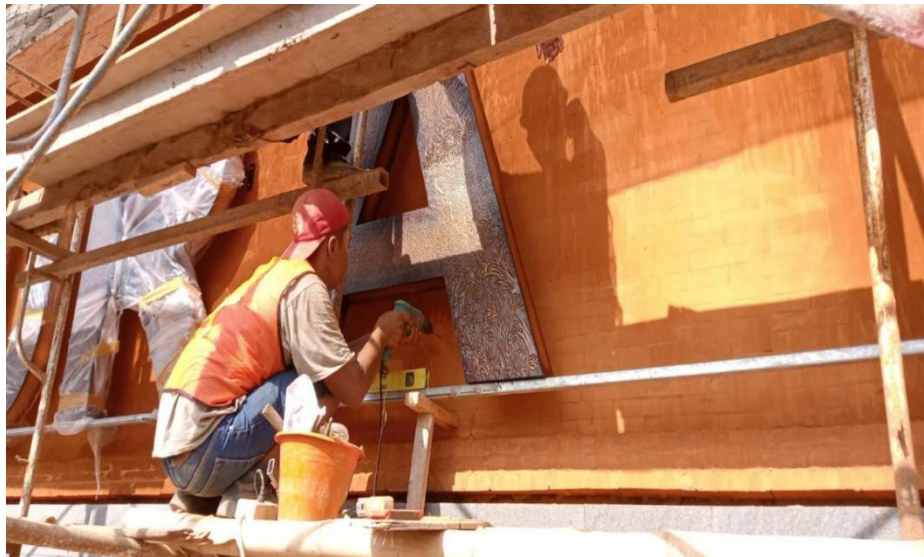
Gambar 4. 13 Dokumentasi proses melubangi tembok (sumber : Dokumentasi pribadi, 2024)
