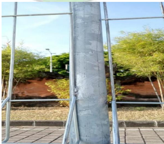
Gambar 4. 20 Pagar yang sudah di baut dan di las (sumber : Dokumentasi pribadi, 2024)
