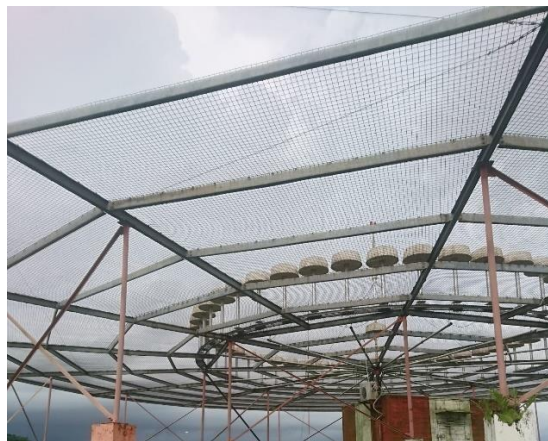
Gambar : 3. 28 Antena DVOR “MAK” Sumber : Dokumentasi Penulis (2024)
