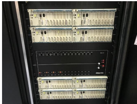
Gambar 3 . 42 Bank Channel Harris Sumber : Dokumentasi Penulis (2024)
