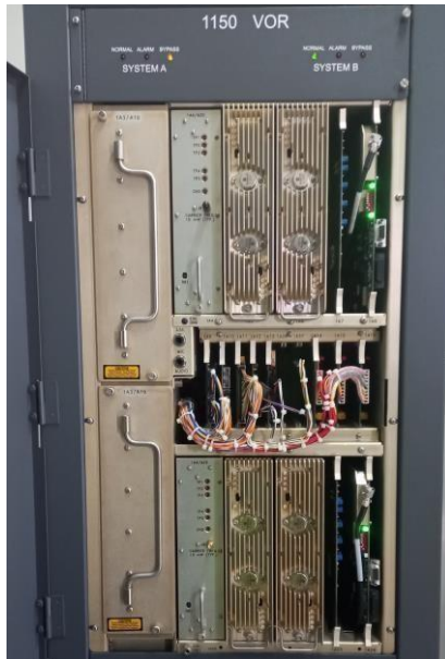
Gambar : 3. 82 Rak Cabinet DVOR “MAK” Sumber : Dokumentasi Penulis (2024)
