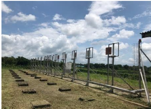
Gambar 3 . 12 Antenna Localizer 13 Sumber : Dokumentasi Penulis (2024)
