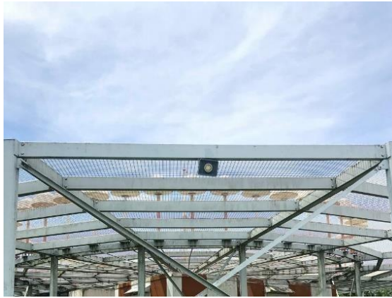
Gambar 3 . 1 Antenna DVOR MKS Sumber : Dokumentasi Penulis (2024)
