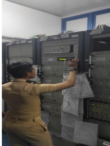
Gambar Lampiran 3. Melaksanakan meter reading pada radio telerad
