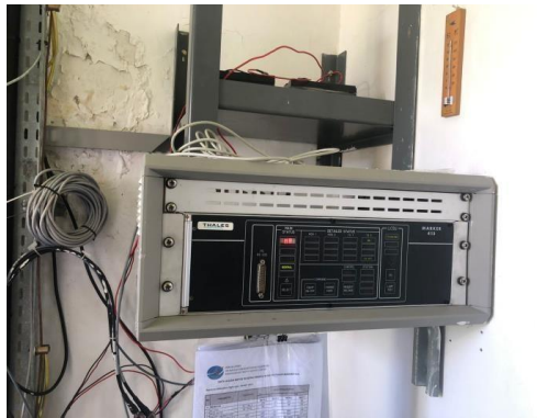
Gambar 3 . 26 Middle Marker Thales Sumber : Dokumentasi Penulis (2024)
