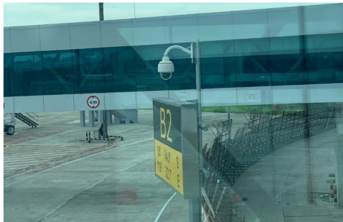
Gambar 3 7 Kamera CCTV PTZ (Pan, Tilt, Zoom)
