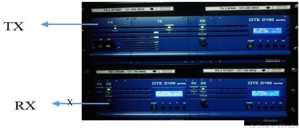
Gambar3. 3 Radio TX dan RX Merk OTE
