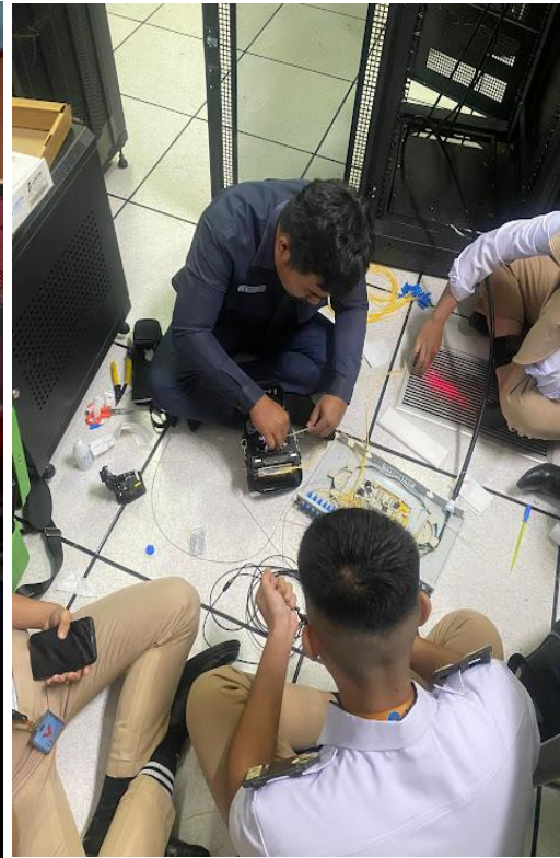
Pengerjaan kabel FO Bersama Teknisi
