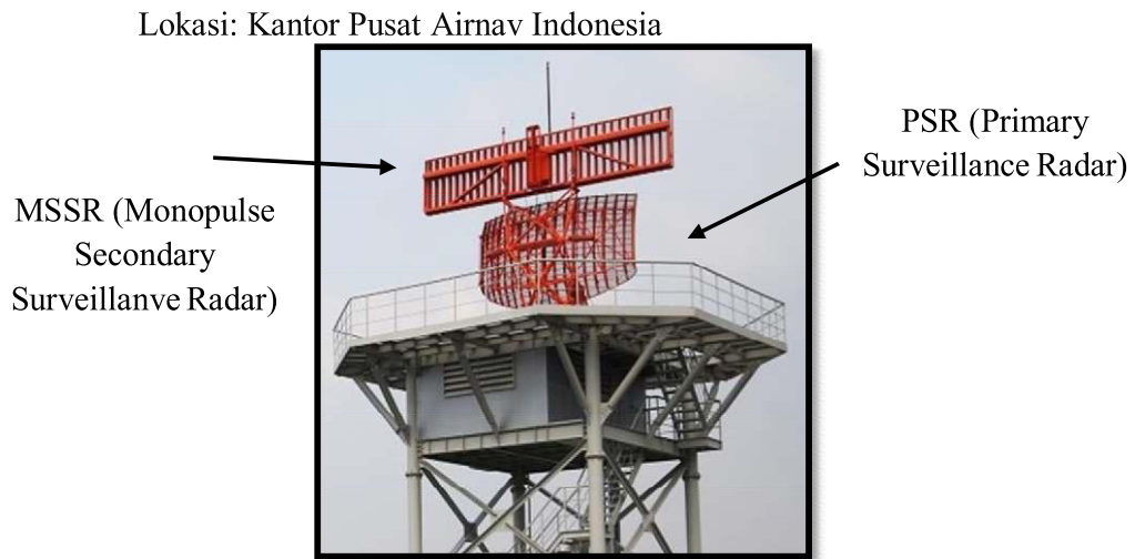
Gambar3. 23 Antena RADAR CKG 3
