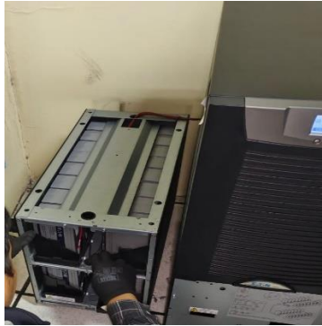
Gambar3. 51 Pemasangan Battery Baru Sumber: Dokumentasi Penulis, 21 November 2024
