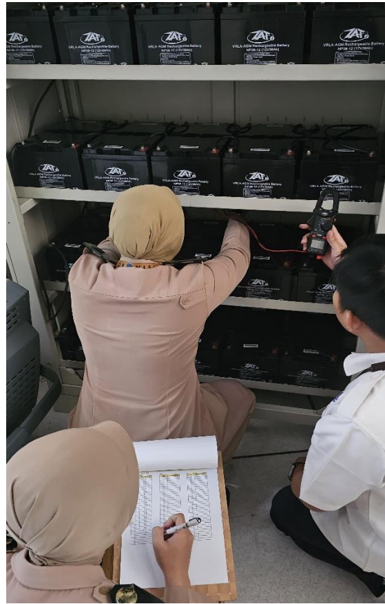
Melakukan pengukuran Battery UPS
