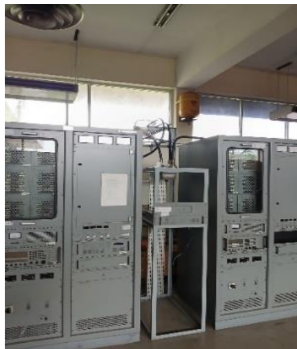
Gambar3. 8 Module RDARA dan MWARA di Gdg.710
