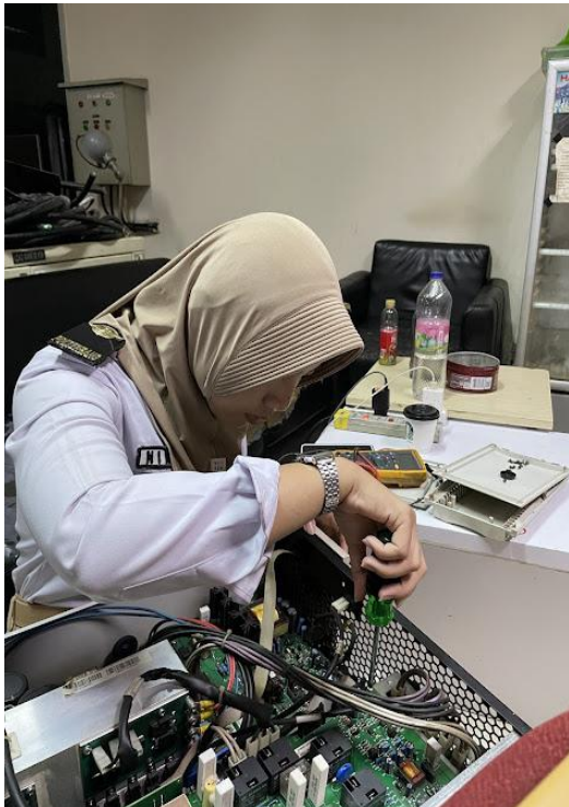
Perbaikan UPS TER
