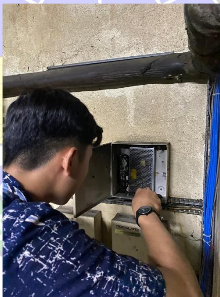
Gambar 3. 17 Pembongkaran Adapter Konverter Ac to Dc Sumber : Dokumentasi Penulis 2025
