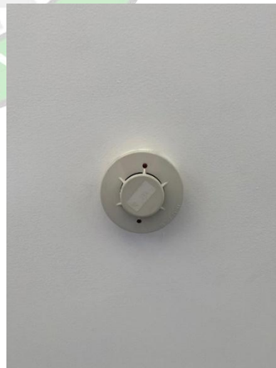
Gambar 3. 13 smoke detector Sumber : Dokumentasi Penulis 2025
