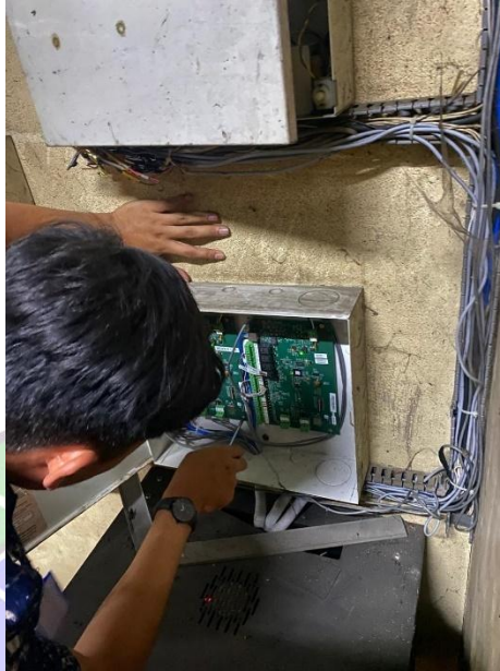
Gambar 3. 18 Pembongkaran Modul Pro3000 Sumber : Dokumentasi Penulis 2025
