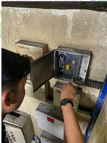
Gambar 3. 19 Pemasangan Adaptor converter Ac to Dc Sumber : Dokumentasi Penulis 2025
