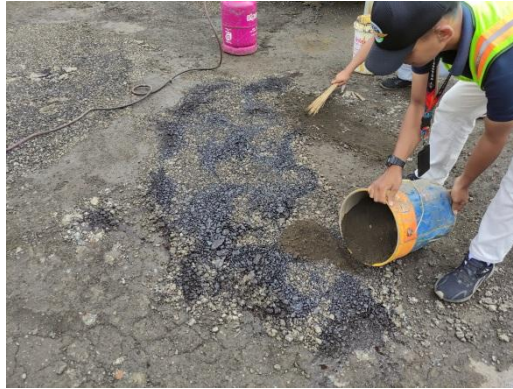
Gambar 4. 19 Penambahan Aspal Emulsi dan Pasir (Sumber : Dokumentasi Penulis,2025)
