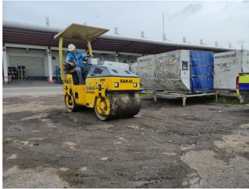
Gambar 4. 17 Pemasatan (Sumber : Dokumentasi Penulis,2025)
