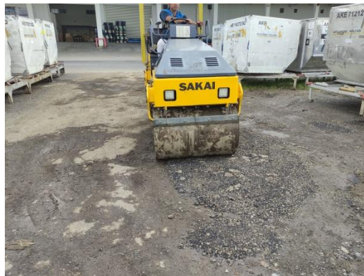
Gambar 4. 20 Pemadatan Kembali dan Finishing (Sumber : Dokumentasi Penulis,2025)
