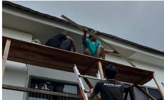
Gambar 4. 22 Pemasangan List Plafon
