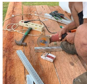
Gambar 4. 19 Pembuatan Sambungan Besi Hollow
