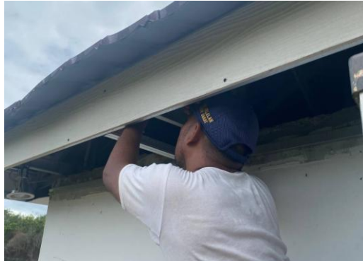
Gambar 4. 20 Penyambungan Besi Hollow (Sumber : dokumentasi penulis, 2024)
