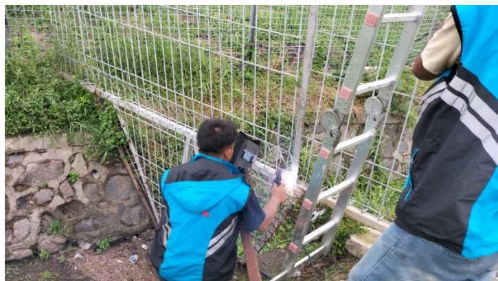
Gambar 4. 39 Pengelasan Besi Siku pada Pagar
