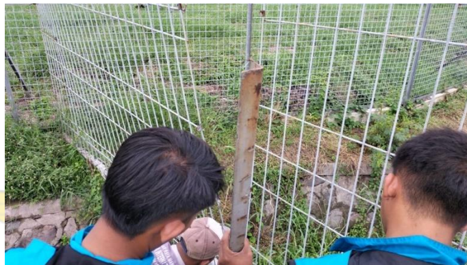
Gambar 4. 38 Pemasangan Besi Siku pada Pagar
