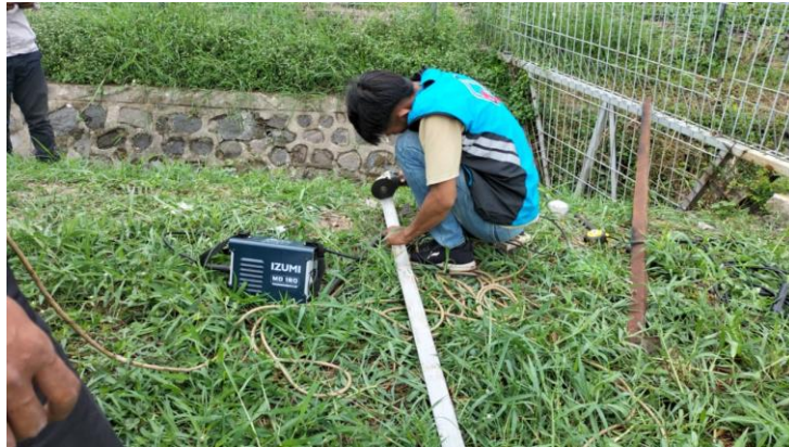
Gambar 4. 37 Pemotongan Besi Siku
