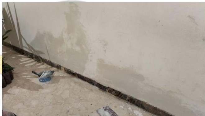
Gambar 4. 30 Hasil Dinding setelah diplamir
