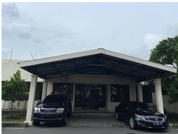
Gambar 4. 20 Gedung Power House
