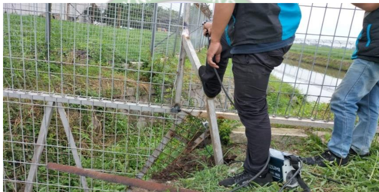
Gambar 4. 41 Pengelasan Besi Ringan pada Pagar
