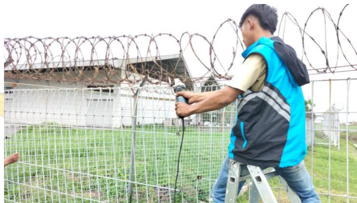
Gambar 4. 35 Pemotongan Sisi Pagar yang Berlebih
