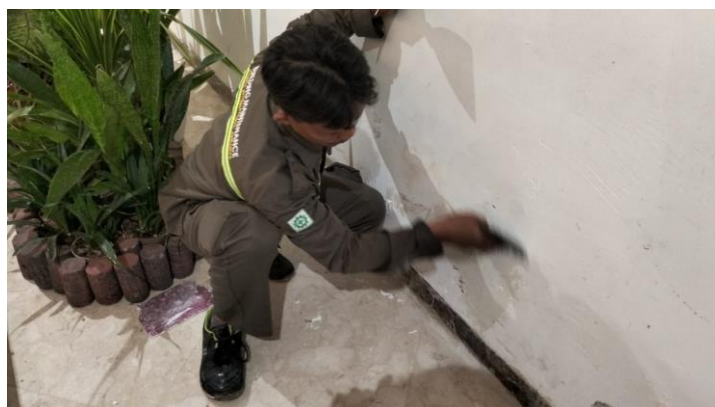
Gambar 4. 28 Pembersihan dinding dengan scraper
