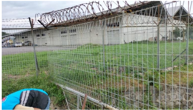
Gambar 4. 34 Perawatan Pagar BRC Sisi Udara
