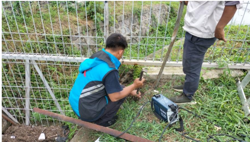
Gambar 4. 40 Membuat Pondasi untuk Penahan Tempat Besi Ringan
