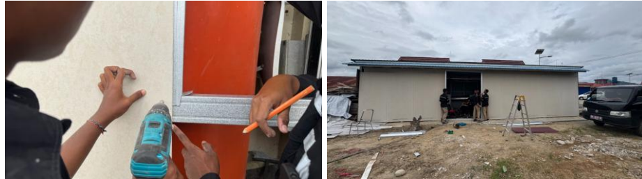
Gambar 4. 24 Pemasangan GRC Board (Sumber: Dokumen Pribadi, 2024)
