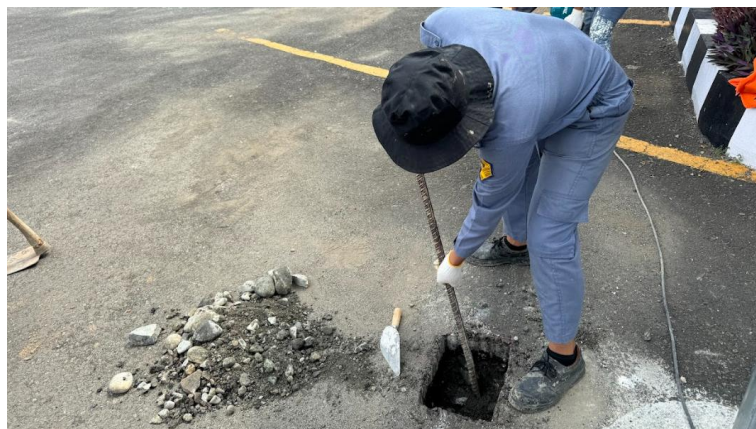
Gambar 4. 13 Pembongkaran Aspal (Sumber: Dokumen Pribadi, 2024)
