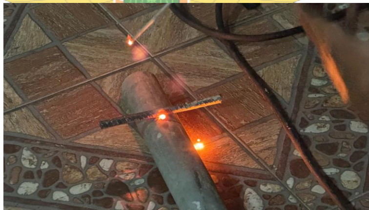
Gambar 4. 15 Pengelasan Anker (Sumber: Dokumen Pribadi, 2024)
