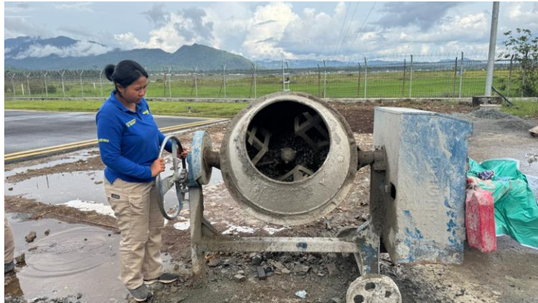
Gambar 4. 16 Pembuatan Campuran Cor Beton
