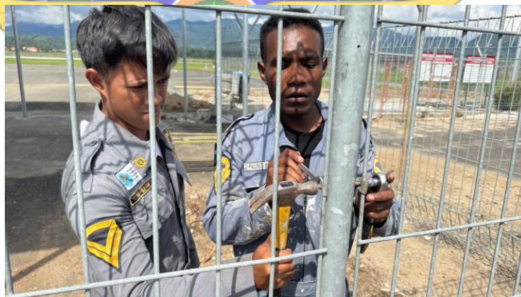
Gambar 4. 19 Pemasangan Sekrup Pagar
