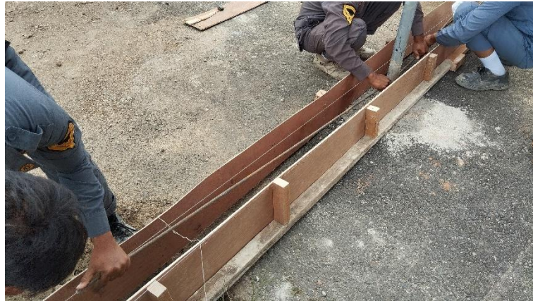
Gambar 4. 18 Pembuatan Bekisting Sloof
