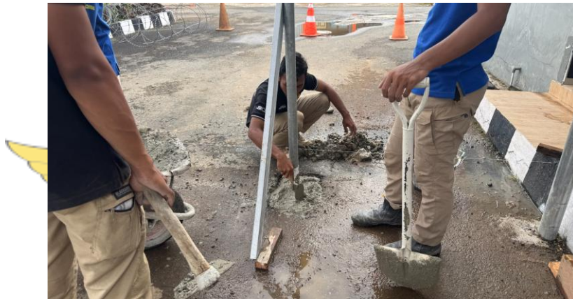
Gambar 4. 17 Pengecoran Pondasi Tiang Besi
