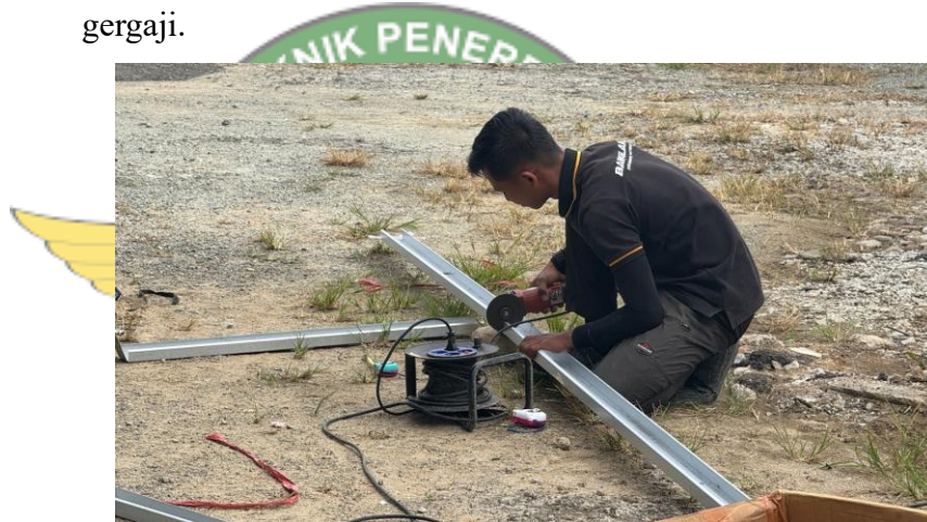
Gambar 4. 22 Pemotongan Taso (Sumber: Dokumen Pribadi, 2024)
