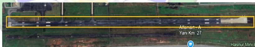
Gambar 4. 12 Runway (Landasan Pacu) (Sumber: Dokumentasi Penulis)
