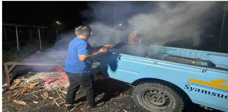
Gambar 4. 20 Proses Pemindahan Hot Mix kedalam Truck (Sumber: Dokumentasi Penulis)
