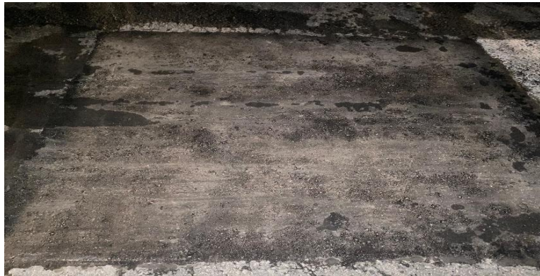
Gambar 4. 29 Kondisi Setelah Dilaksanakannya Patching (Sumber: Dokumentasi Penulis)
