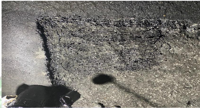
Gambar 4. 23 Proses Penyiraman Tack coat (Sumber: Dokumentasi Penulis)
