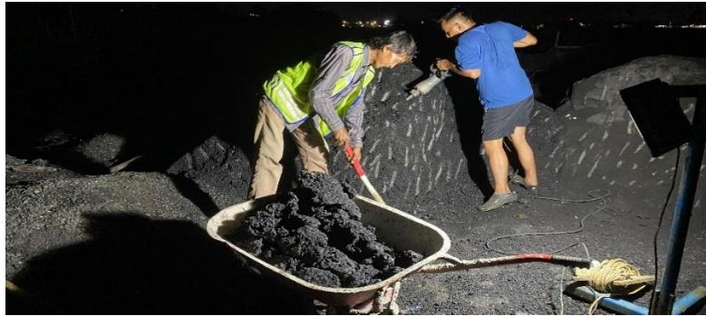
Gambar 4. 17 Proses Pengangkutan Asphalt (Sumber: Dokumentasi Penulis)
