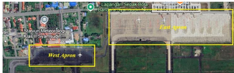
Gambar 4. 13 Apron (Sumber: Dokumentasi Penulis)
