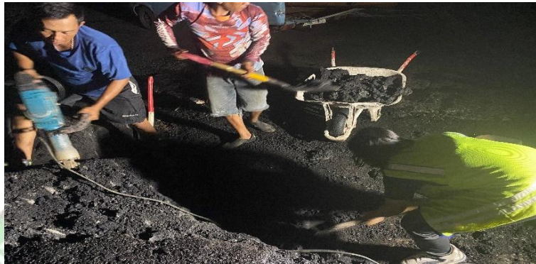
Gambar 4. 15 Proses Penggemburan Asphalt (Sumber: Dokumentasi Penulis)
