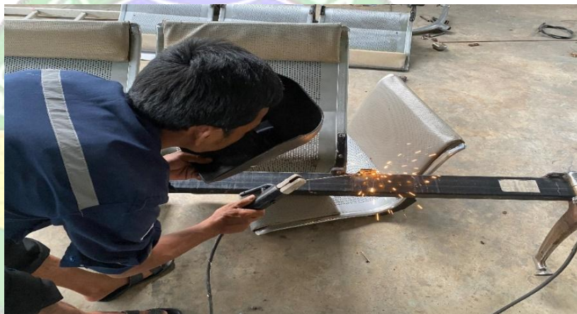
Gambar 4. 36 Proses Pengelasan Tiap Sudut Kursi (Sumber: Dokumentasi Penulis)
