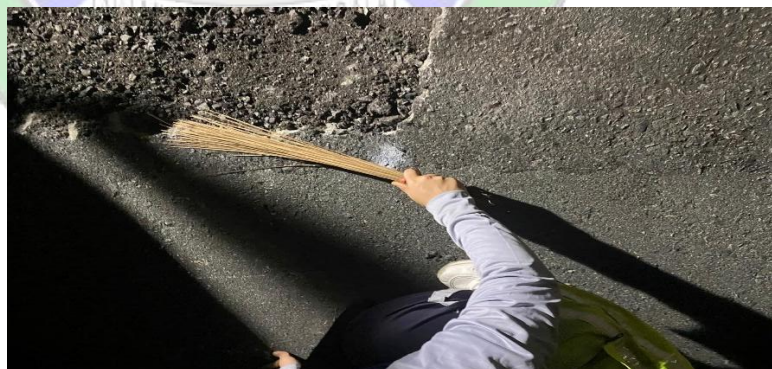
Gambar 4. 22 Pembersihan Area Galian (Sumber: Dokumentasi Penulis)
