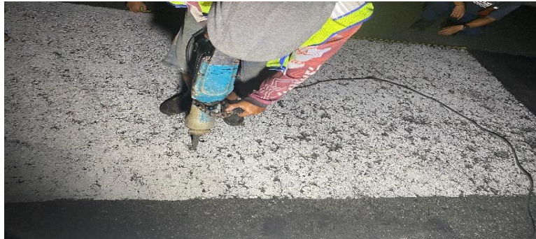
Gambar 4. 21 Pemotongan pembongkaran (Sumber: Dokumentasi Penulis)
