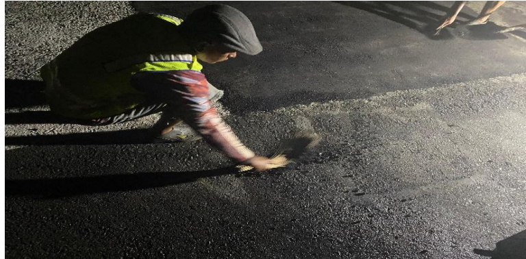
Gambar 4. 27 Pembersihan Lokasi Setelah Patching (Sumber: Dokumentasi Penulis)
