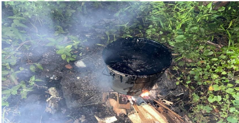
Gambar 4. 19 Pembuatan Tack coat (Sumber: Dokumentasi Penulis)
