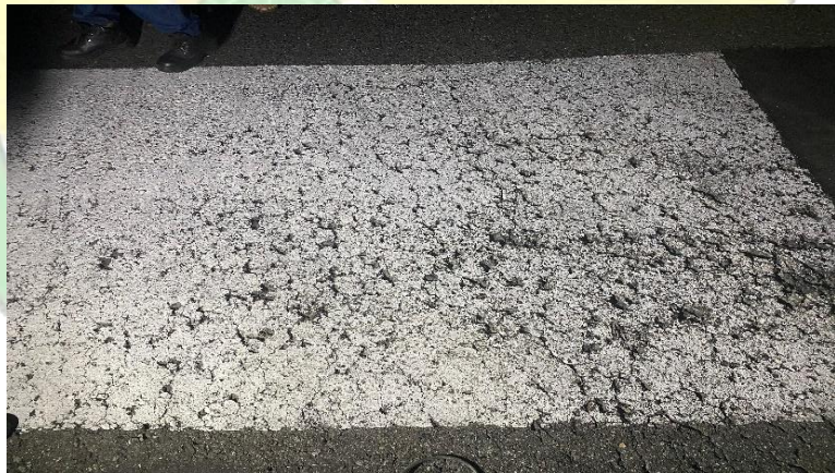
Gambar 4. 28 Kondisi sebelum dilaksanakannya patching (Sumber: Dokumentasi Penulis)
