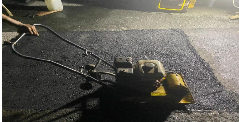
Gambar 4. 25 Proses Pemadatan Menggunakan Stamper (Sumber: Dokumentasi Penulis)
