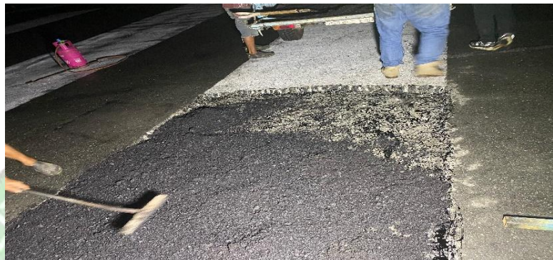
Gambar 4. 24 Proses Penghamparan Asphalt (Sumber: Dokumentasi Penulis)
