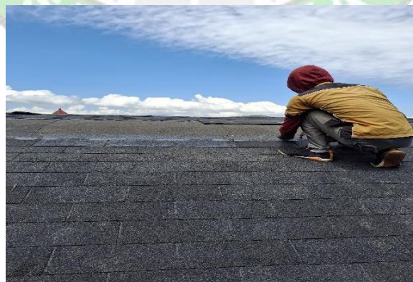
Gambar 4. 14 Pemasangan Bitumen Sumber: Olahan Penulis,2025
