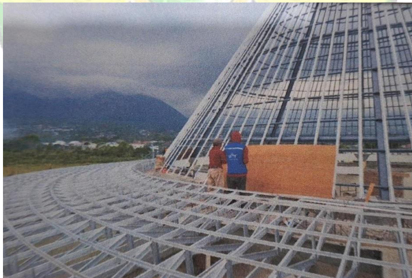
Gambar 4. 12 Pemasangan Multiplek Sumber: Olahan penulis 2025
