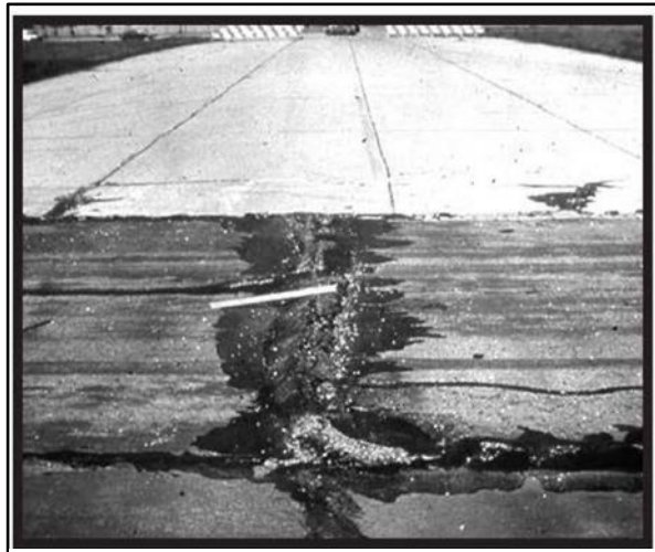
Gambar 3. 6 Retak Mengembang Sumber: KP 94 Tahun 2015
