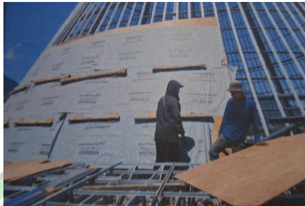
Gambar 4. 13 Pemasangan Storm Guard atau Membran Sumber: Olahan penulis 2025
