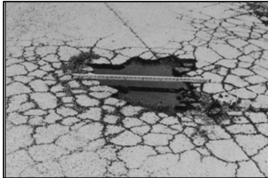
Gambar 3. 5 Retak Lubang Sumber: KP 94 Tahun 2015
