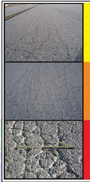
Gambar 3. 3 Retak Kulit buaya Sumber: KP 94 Tahun 2015
