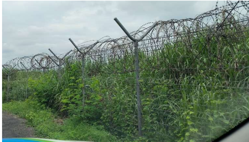
Gambar 4.4 Pagar Perimeter Yang Tertutup Vegetasi
