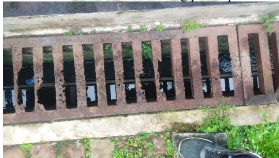
Gambar 4. 22 Grill besi eksisting penutup selokan
