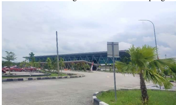
Gambar 4. 1 Bangunan Terminal Penumpang
